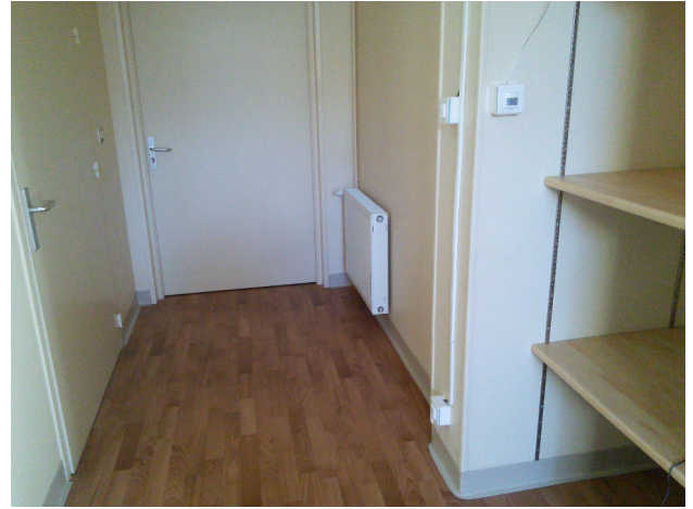
(b) Capteurs PIR installés au niveau du couloir
