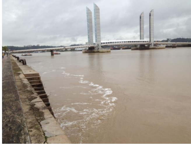
Figure 34. Rejet de la station Louis Fargue à Bordeaux
