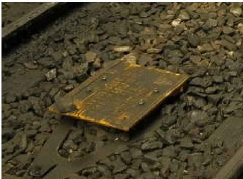
Figure 1.1 : Vue externe de la balise KVB installée en voie
