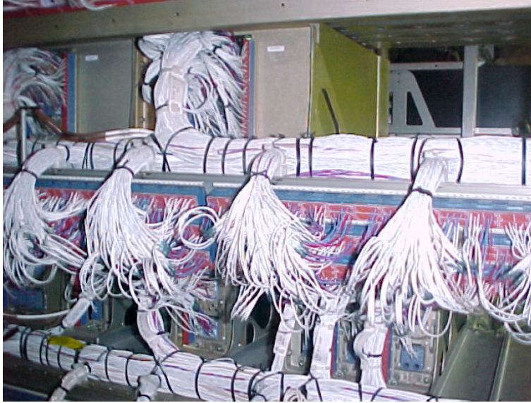
FIGURE 1.7 – Câblage à l'arrière du race électrique d'un avion de transport en service (source :[58]).
