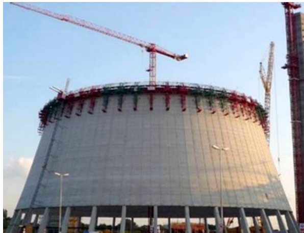
Figure 1.3 Système de coffrage grimpant
