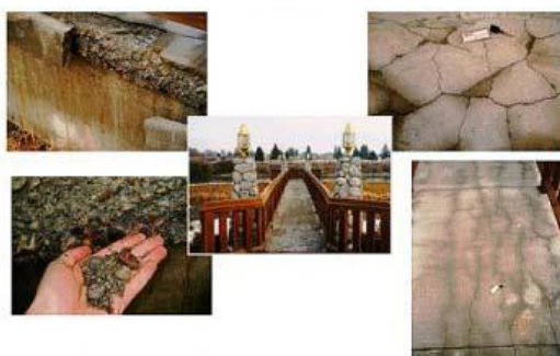
(d) Désordres dus au cycle gel/dégel
