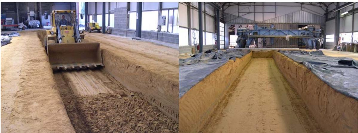
Figure 7.3 : Réalisation de la tranchée dans l'encaissant.
