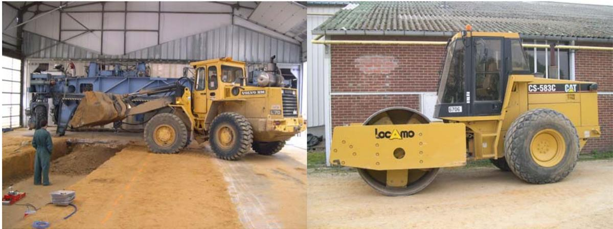
Figure 7.4 : Mise en œuvre d'une couche de limon (à gauche) et compacteur utilisé (à droite).
