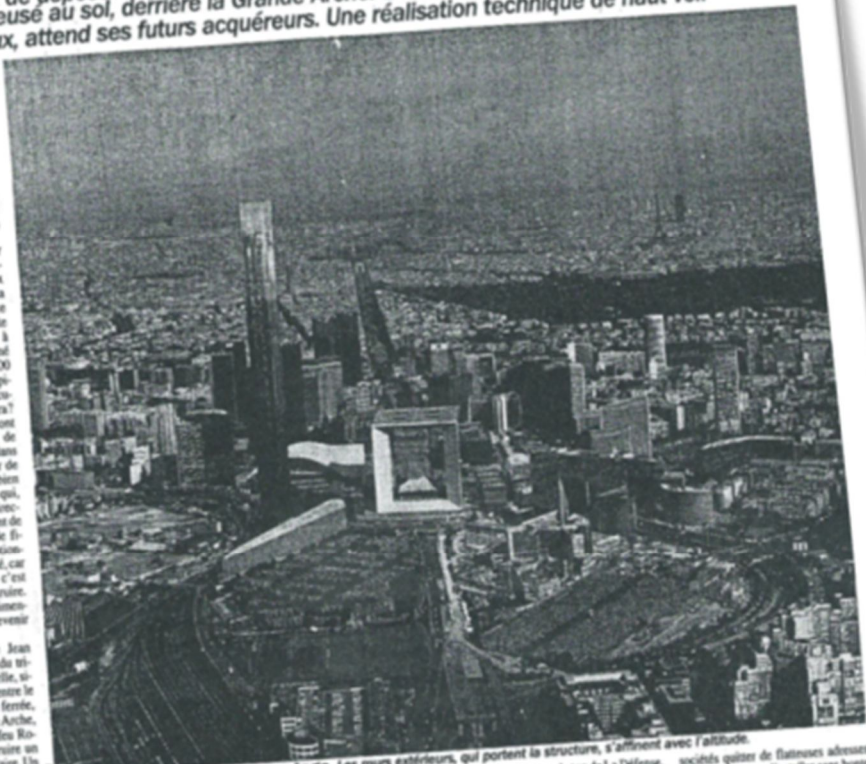
La tour de Nouvel, photomontage. Les murs extérieurs, qui portent la structure, s'affinent avec l'altitude.
