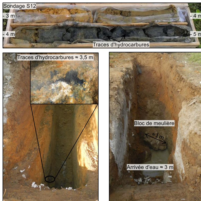
Figure 3-7 : Traces d'hydrocarbures relevées dans les sols lors de la réalisation du sondage S12 en juin 2012 (photo du haut) et d'une tranchée drainante en juillet 2013 (photo du bas à gauche) et précision du contexte géologique (photo du bas à droite).
