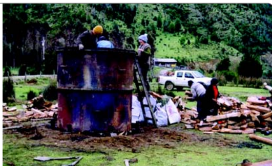
Figura 153. Proceso de carga de horno metálico portátil.
