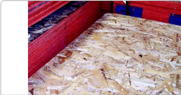
Figura 69. Vista general de Tableros OSB.
