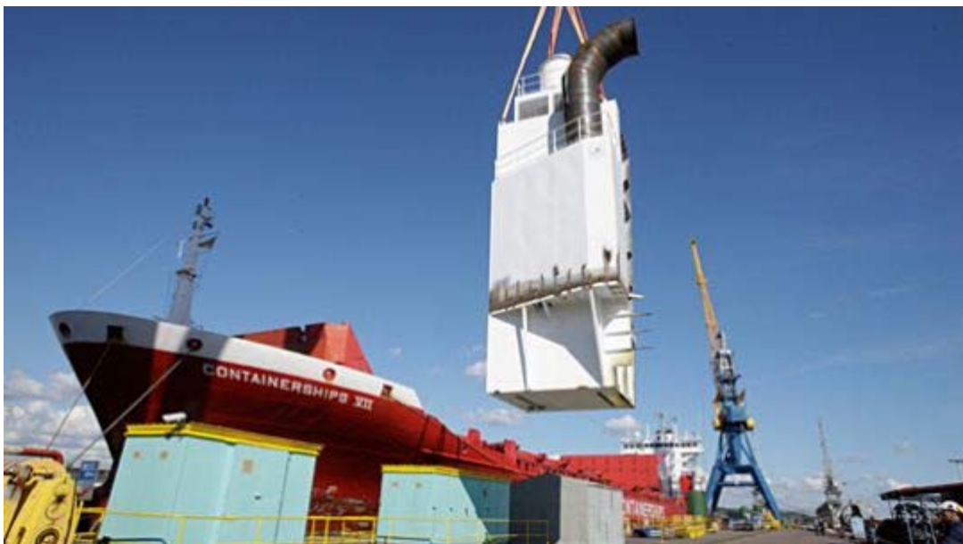
Figura 24: Procés d'instal·lació d'un “scrubber” en una embarcació. Es pot apreciar el tamany real d'aquest.
