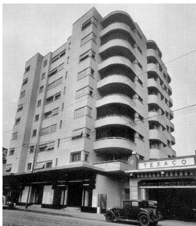
Ilustración 29 - Edificio Columbus, São Paulo. Fuente: www.estacoesferroviarias.com.br . Acceso en 08/2013
