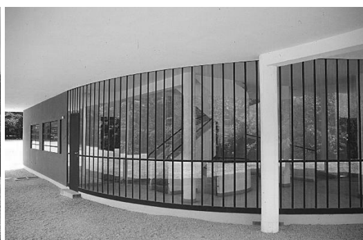
Ilustración 7 – “Pilotis” y cerramiento del núcleo central, independiente de la estructura. Villa Savoye (1914). Proyecto de Le Corbusier. Fuente: www.bc.edu . Acceso en 10/2013
