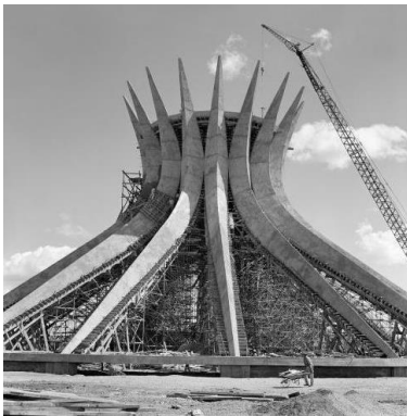
Ilustración 47 - Construcción de la Catedral de Brasilia. Arquitecto Oscar Niemeyer. Fuente: www.incriveisobras.blogspot.com . Acceso en 08/2013
