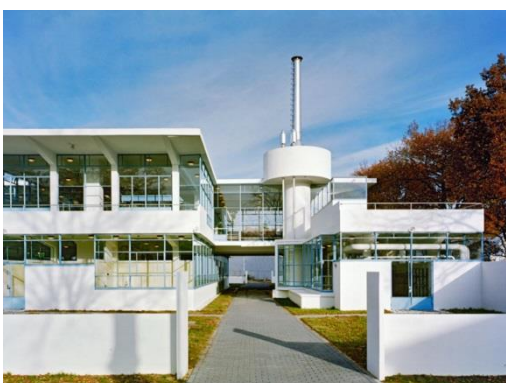
Ilustración 10 – Restauración del Sanatorio Zonnestral. Fuente: www.wmf.org . Acceso en 10/2014
