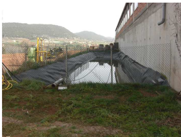
Figura 5: Bassa exterior Font: Pròpia
