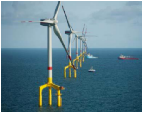
Figura 1.18. Cimentación tripilote.
