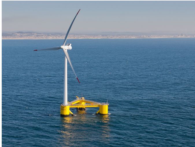
Figura 1.23. Estructura semisumergible (WindFloat) [13].
