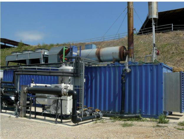
Figura 5.3.4. Motor de cogeneración alimentado por biogás
