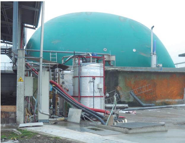
Figura 6.5.1. Digestión anaerobia, reactor CSTR y contenedor de gas (gasómetro) en Campo Bò (Emilia Romagna, Italia).
