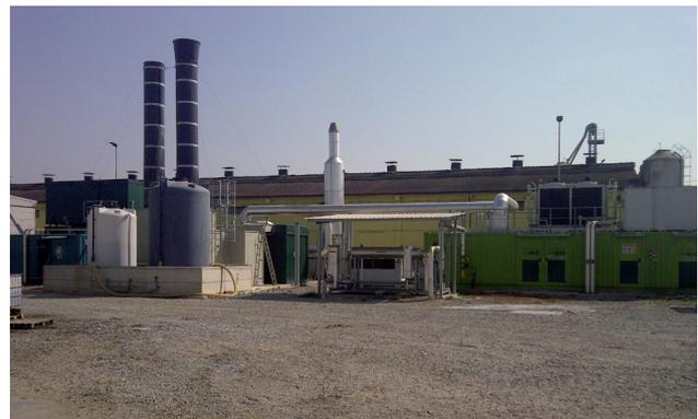
Figura 5.7.2. Planta de secado con el lavador y la unidad de cogeneración. Granja Green Energy - Brescia, Italia (CRPA, 2015).
