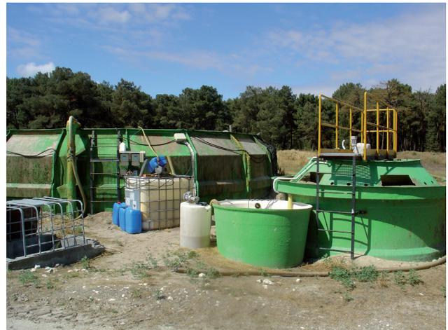
Figura 6.7.2. Tratamiento biológico aeróbico + decantación de la planta de tratamiento de Cuéllar (Castilla y León, España).
