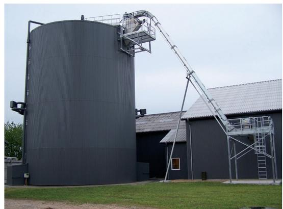
Figura 6.3.2. El reactor principal con la nueva cinta de carga de sólidos/ con un sistema de tornillo.
