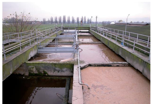
Figura 5.4.3. Proceso aerobio con aireación (izquierda) y fase anóxica (derecha) en diferentes depósitos. En primer plano el depósito de sedimentación.
