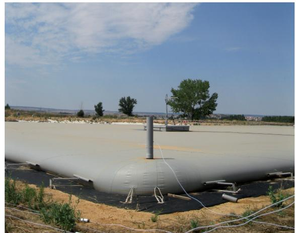
Figuras 6.2.7 y 6.2.8. Medición de emisiones en las balsas de almacenamiento de digerido en la planta de tratamiento de Purines Almazán, SL (Castilla y León, España).
