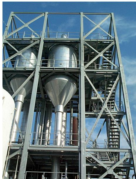
Figura 5.6.2. Evaporador al vacío. Planta de tratamiento Tracjusa [Cataluña, España]
