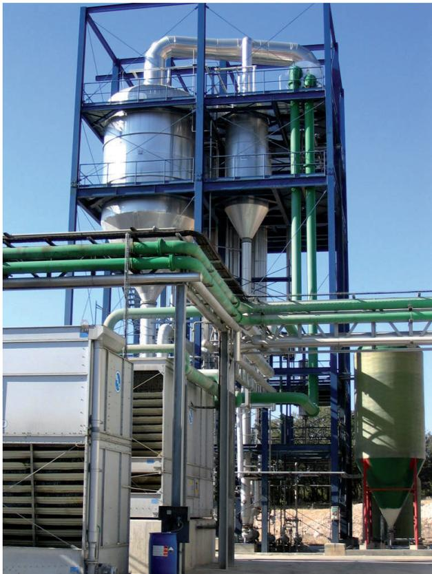
Figura 5.6.4. Evaporador al vacío. Planta de tratamiento de Langa de Duero (España).
