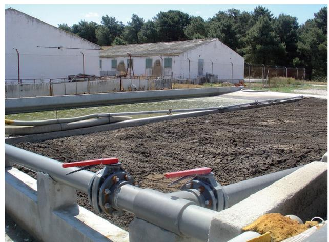
Figura 5.2.9. Balsas de coagulación-floculación con una pendiente para retirar los sólidos.
