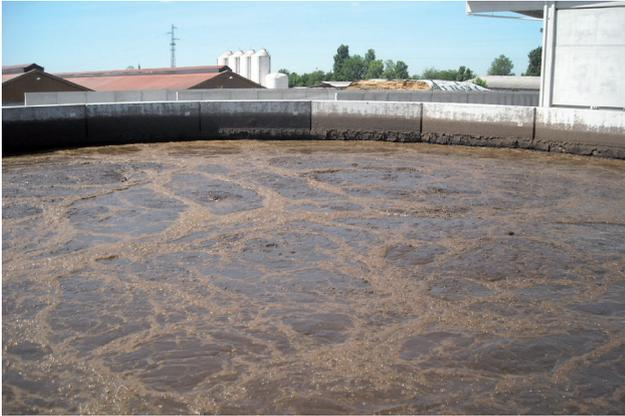
Figura 5.4.4. Proceso de eliminación de nitrógeno en reactores biológicos secuenciales (SBR). El depósito está en la fase aerobia (nitrificación).
