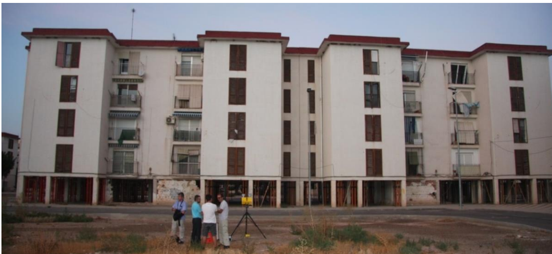
Figura 4-1 Edificio de viviendas sociales del barrio de San Fernando
