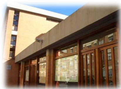
Figura 14. Escola Gaudí de Sabadell. (Fotografia extreta de la pàgina web: ( http://www.xtec.cat/escolagaudisabadell/ )).
