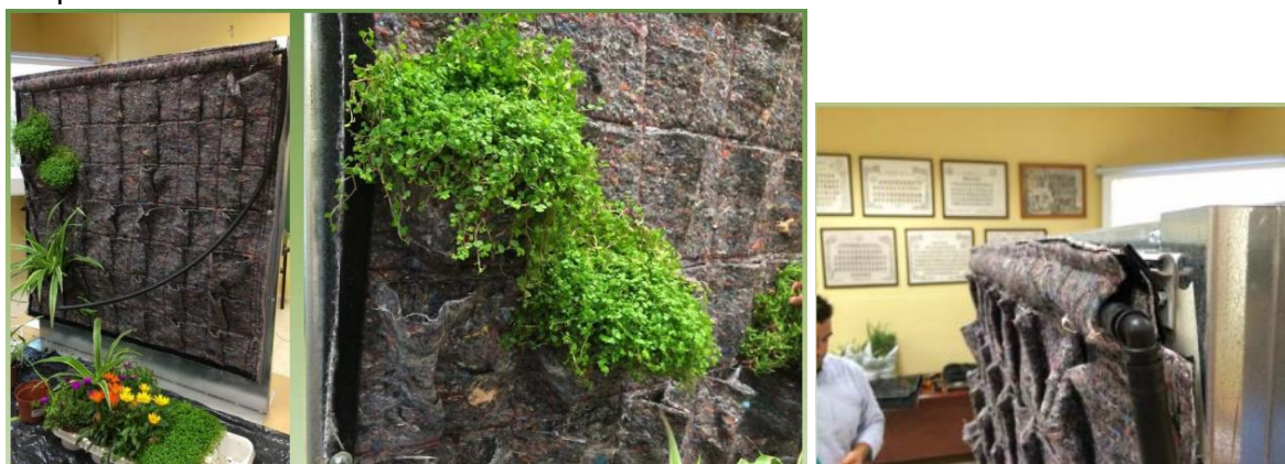
Εικόνες 1.22. τρόπος εγκατάστασης των καθέτων κήπων από γεωύφασμα [πηγή: (N.Ντούλας, 2015) ]
