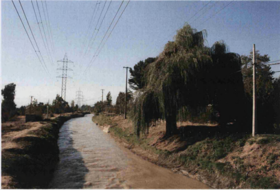
Photo -7. Canal Las Perdices
