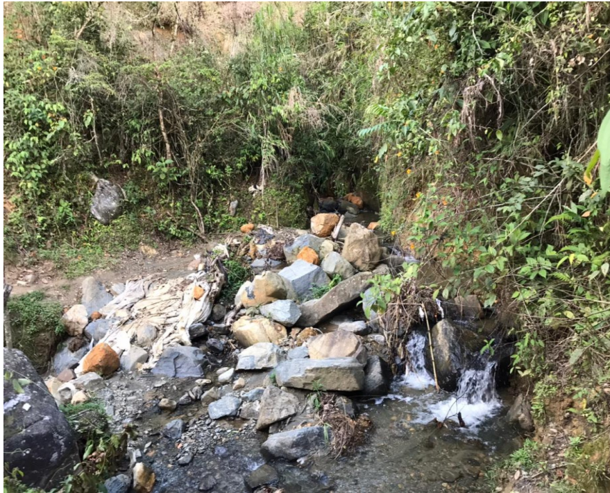
ILUSTRACIÓN 15 QUEBRADA AGUAS FRÍAS SECTOR TRAVESÍAS
