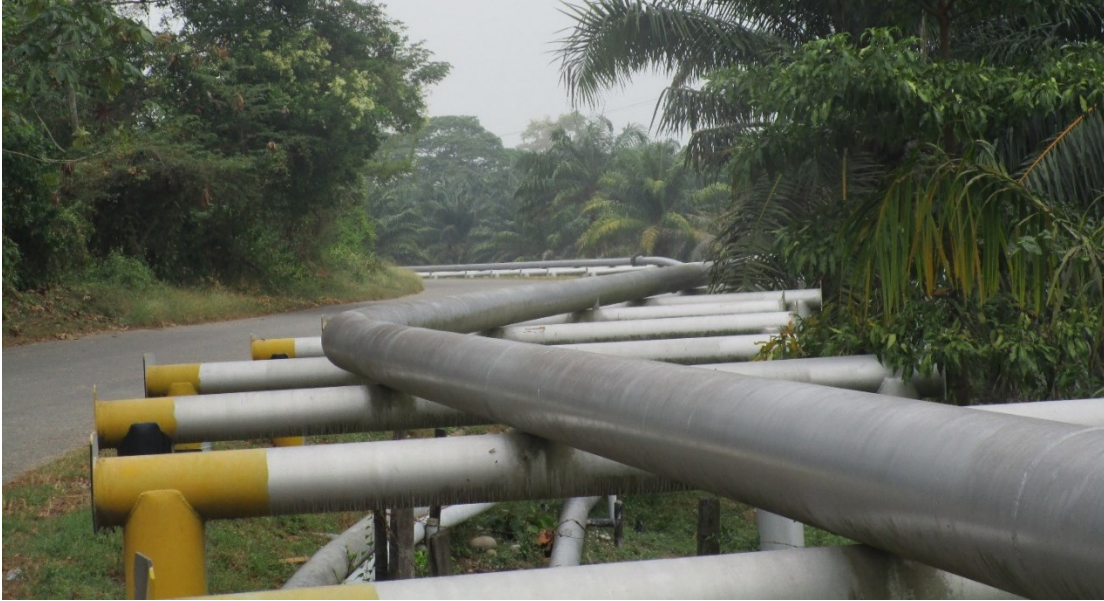
Gráfica 17. Tubería de acero para conducción de hidrocarburos
