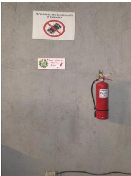
Ilustración 23 Extintor mal ubicado y sin señalización adecuada.
