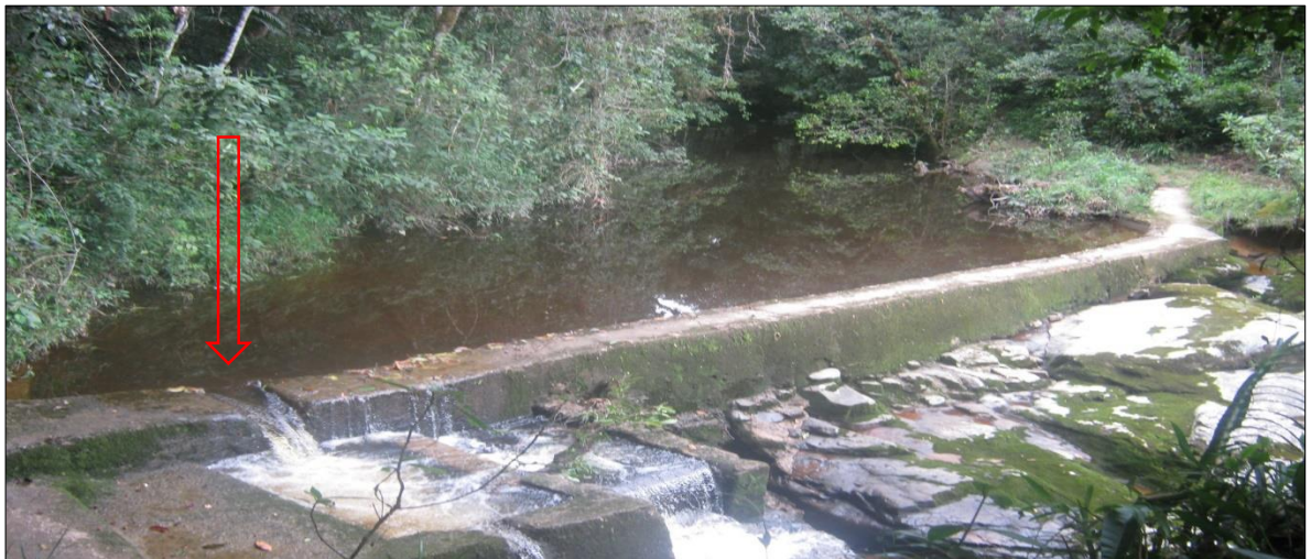
Fotografía 9. Vertedero hacia la cámara de captación.
