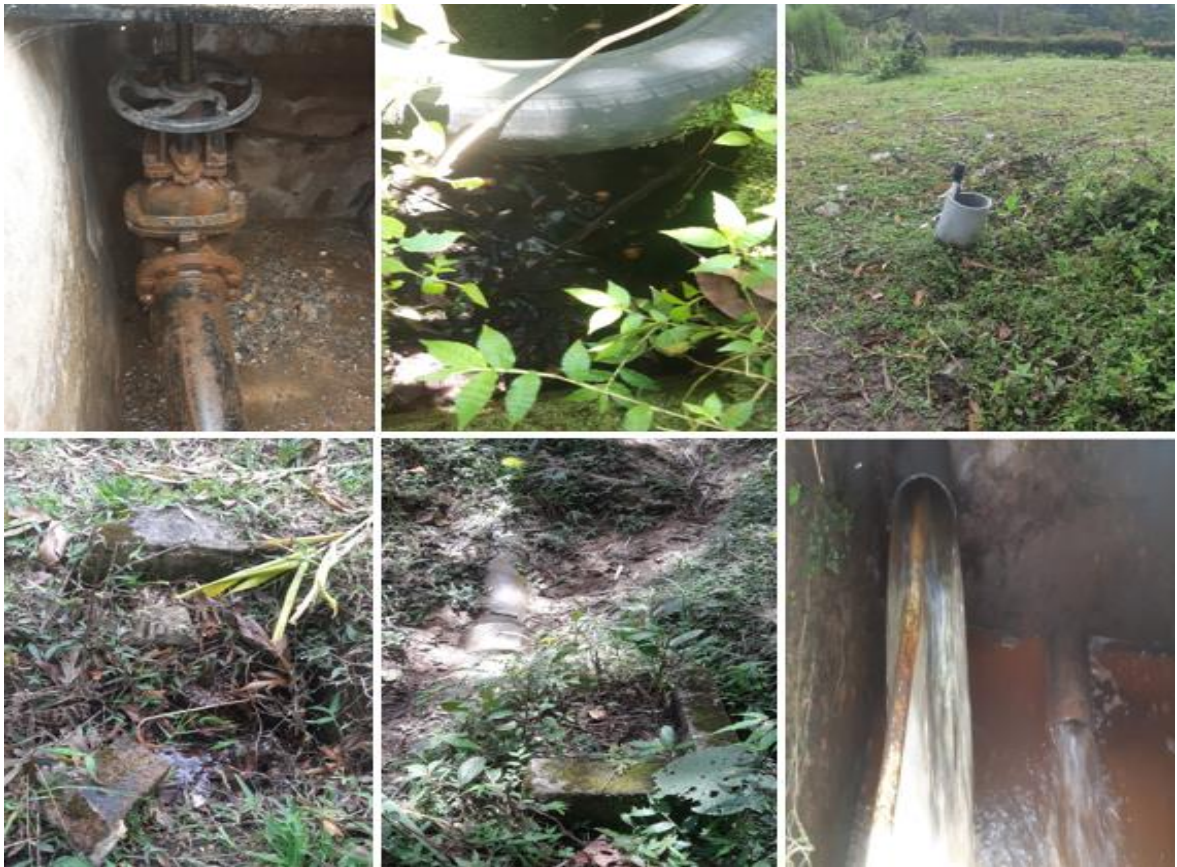
Fotografía 19. Registro de estado estructural de algunas cámaras y su comportamiento hidráulico.
