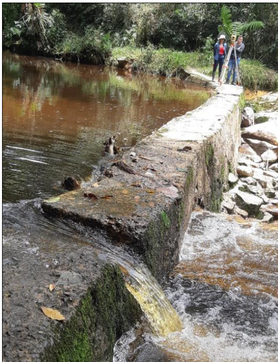
Fotografía 5. Levantamiento convencional por estación total, para la captación, línea de aducción y desarenador.
