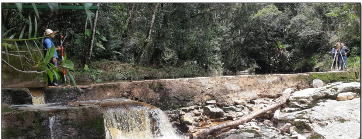
Fotografía 7. Levantamiento topográfico de la estructura de la bocatoma.
