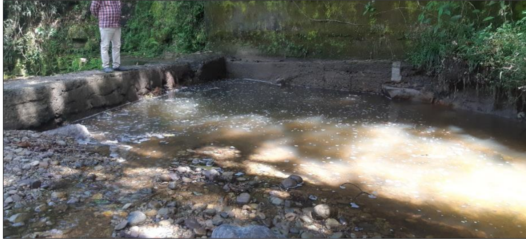
Fotografía 8. Bocatoma aguas arriba del muro tipo presa.
