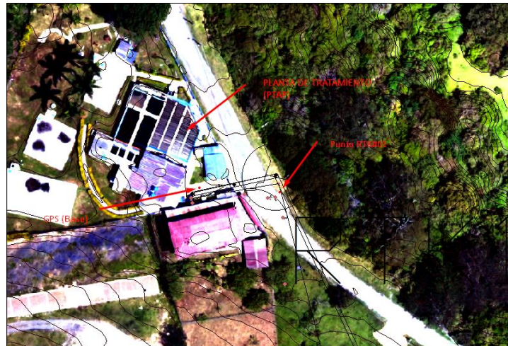
Fotografía 3. Fotografía aérea de la planta de tratamiento PTAP, el punto Base estático y el primer punto RTK#01.
