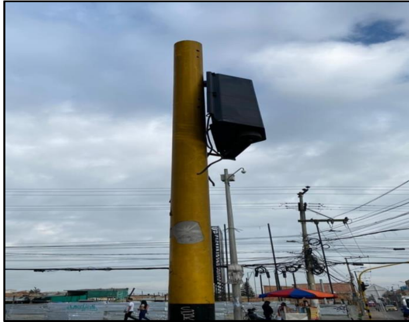
Ilustración 15. Semáforo en mal estado.
