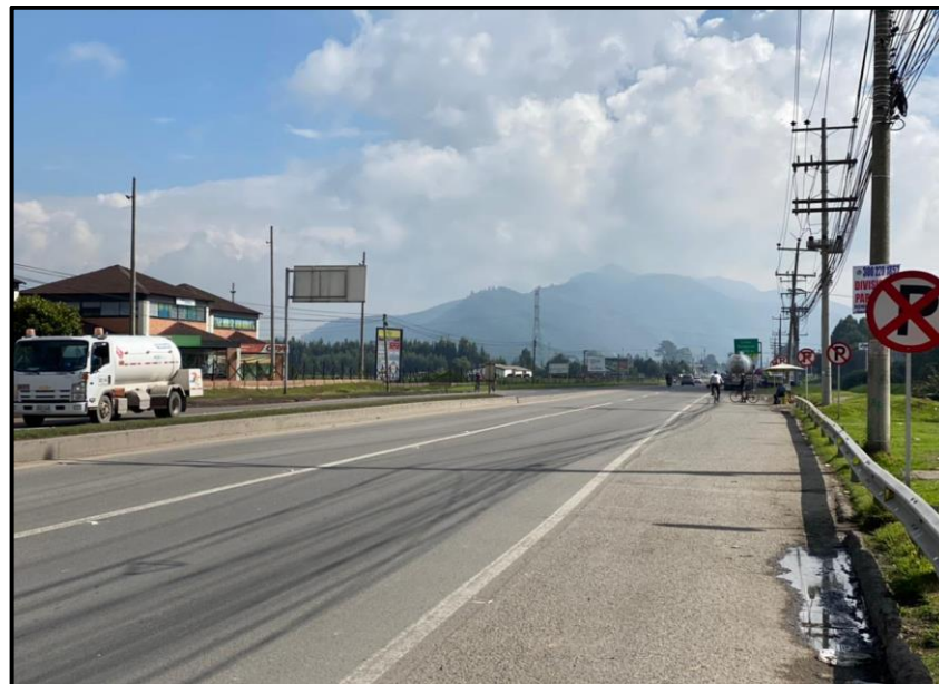
Ilustración 26. Capa de rodadura.
