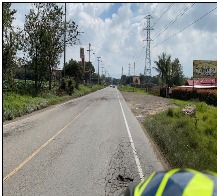
Ilustración 30. Inicio Tercer Tramo.
