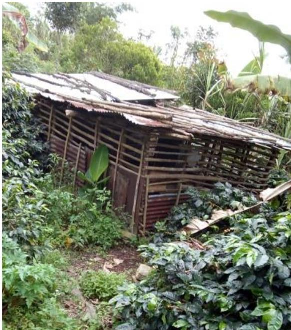
Nota. Esta imagen muestra el uso de la guadua como estructura y las tejas metálicas en cubierta de la vivienda rural.
