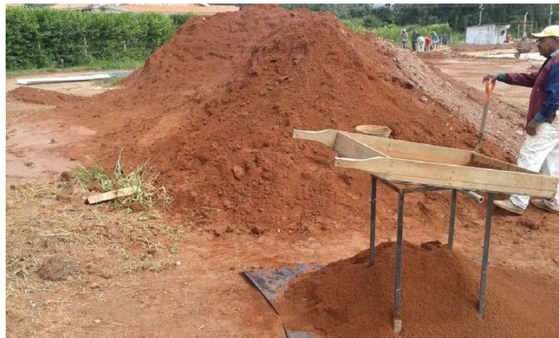
Imagen 27 Tierra de excavación In Situ.
