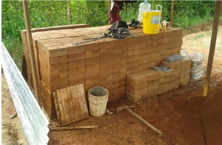
Imagen 32 Curado de los bloques. Fuente: Propia.
