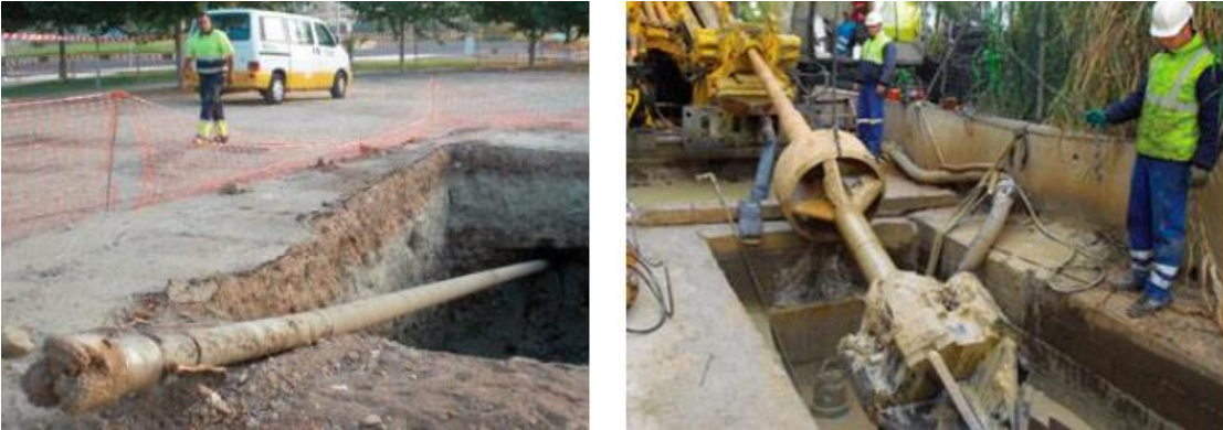
Figura 9. Cabeza de perforación y escariador.
