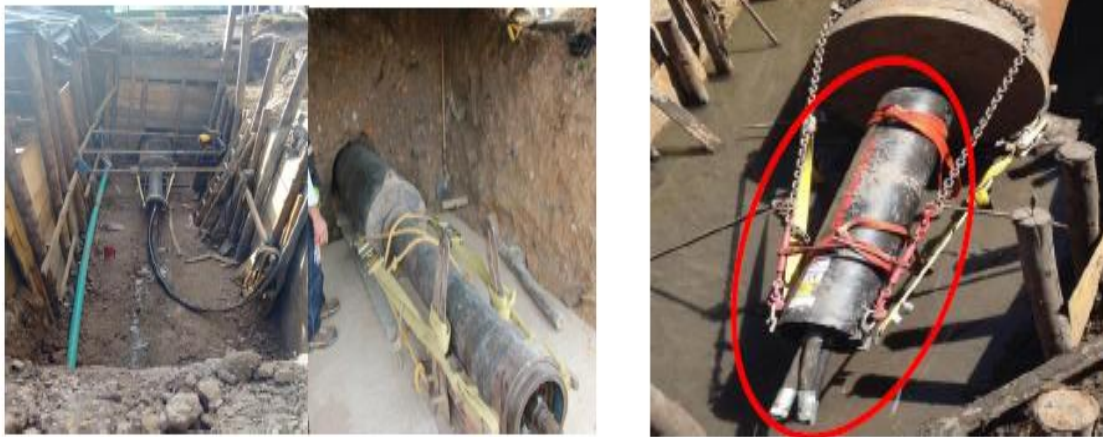
Figura 6. Equipo Ramming y Martillo hidráulico.
