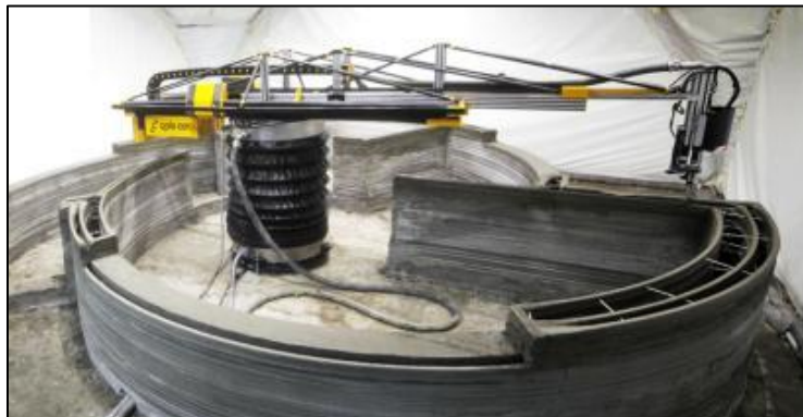
Ilustración 1.1.6 Extrusor empleado por Apis Cor. Imagen recuperada de (3dnatives, s.f.)
