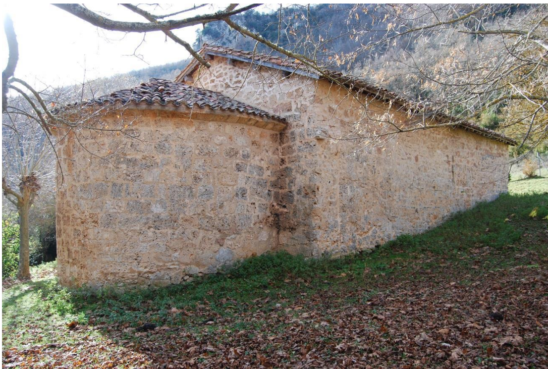
Figura 39. Ermita de San Pedro. Fachada norte. (Fotografía de la autora)
