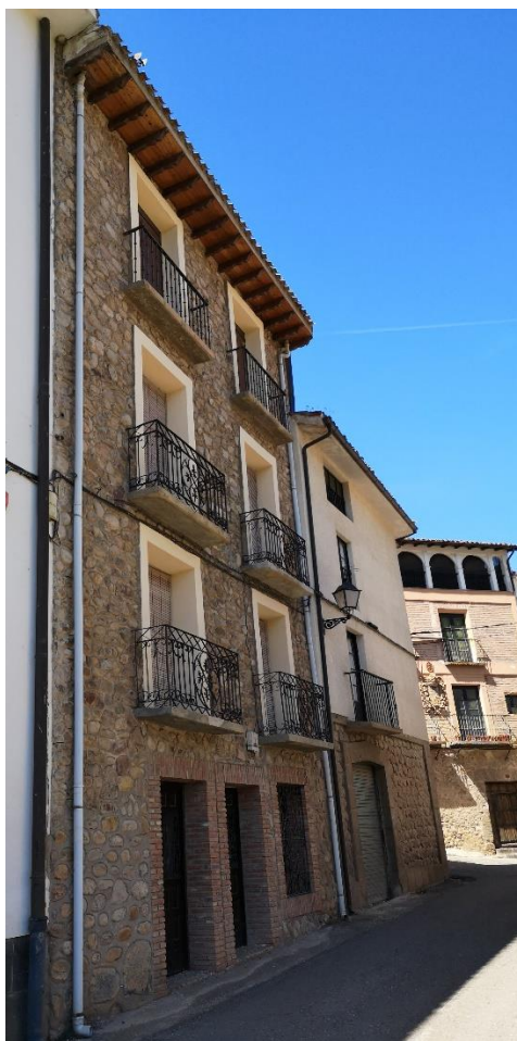
Figura 91. Edificio C/ Pedro Sagasta, 18. (Fotografía de la autora)
