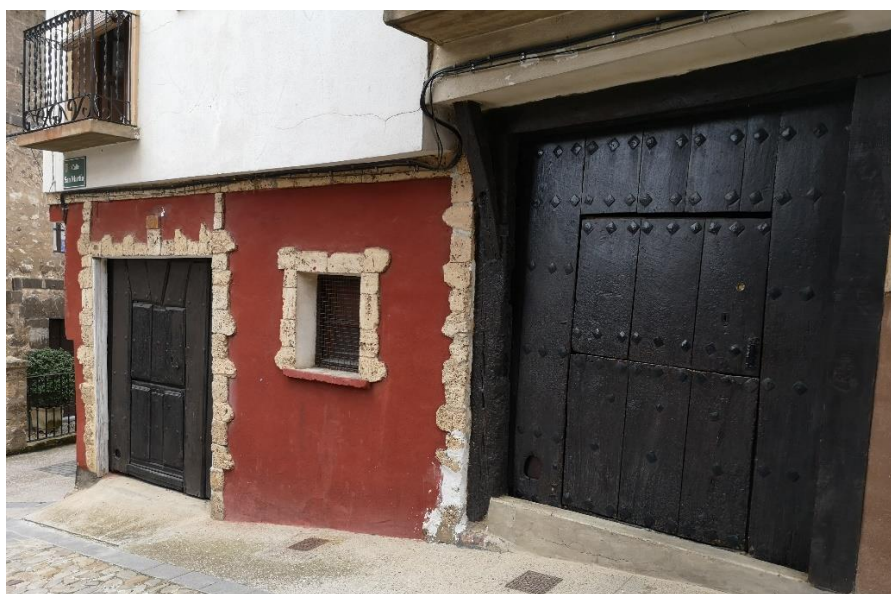
Figura 103. Edificios plaza San Martín 5 y 6. (Fotografía de la autora)
