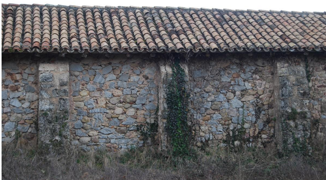
Figura 29. Ermita de San Andrés. Vegetación arraigada en los muros. (Fotografía de la autora)
