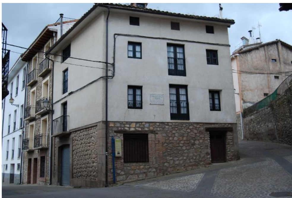
Figura 92. Edificio C/ Pedro Sagasta, 20. (Fotografía de la autora)
