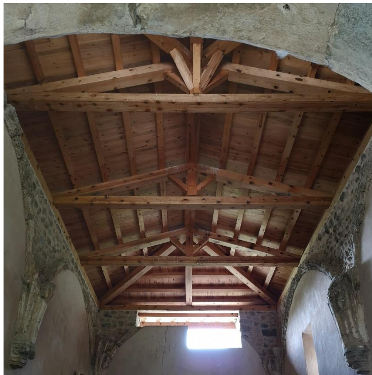
Figura 34. Ermita de San Lázaro. Cubierta interior y arranques de crucerías. (Fotografía de la autora)
