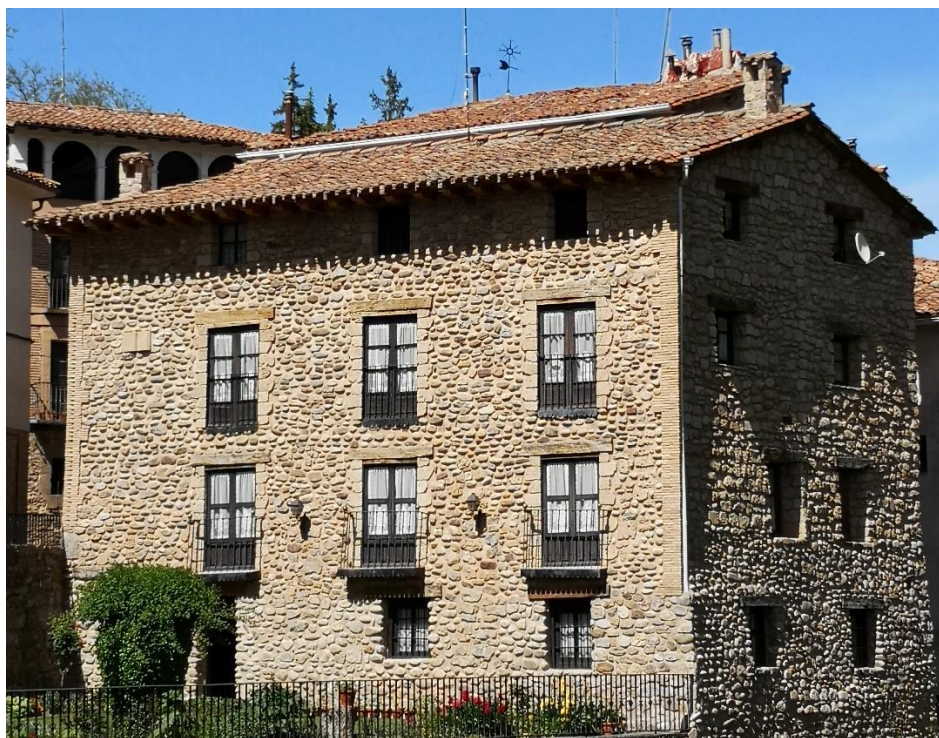
Figura 93. Edificio C/ Pedro Sagasta, 22. (Fotografía de la autora)
