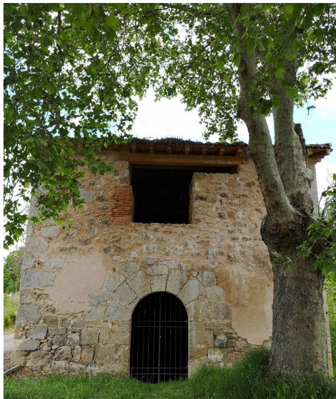
Figura 32. Ermita de San Lázaro. Ingreso y vano. (Fotografía de la autora)
