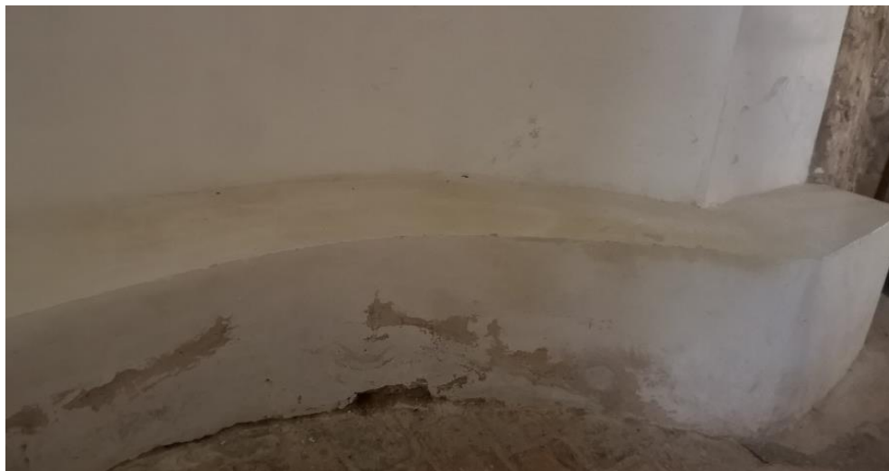
Figura 30. Ermita de San Andrés. Deterioro del banco por humedad. (Fotografía de la autora)
