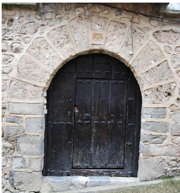
Figura 94. Edificio C/ Pedro Sagasta, 25. (Fotografía de la autora)
