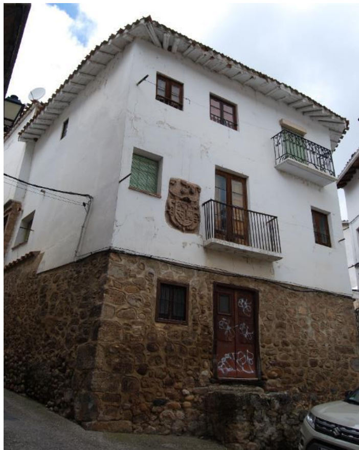
Figura 99. Edificio C/ Pedro Sagasta, 1A. (Fotografía de la autora)
