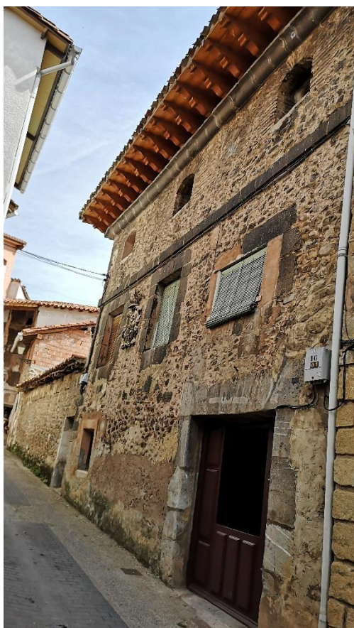
Figura 98. Edificio C/ Padre Cámara, 16. (Fotografía de la autora)
