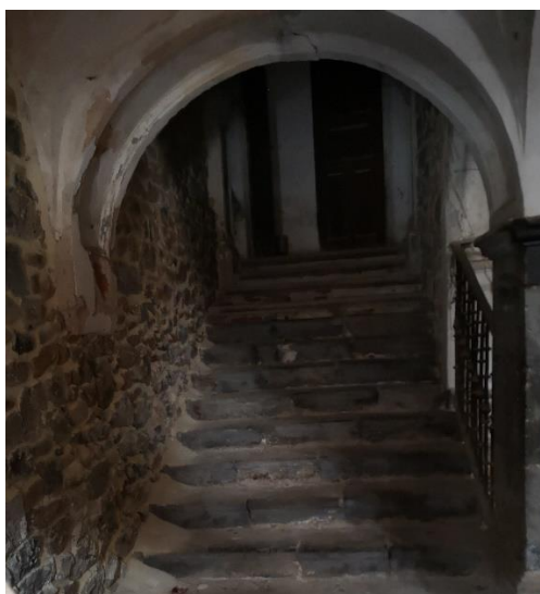
Figura 111. Edificio C/ Padre Cámara, 1. Escalera interior. (Fotografía de la autora)
