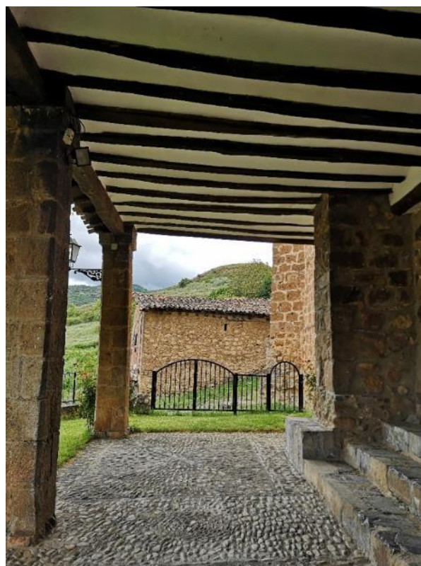
Figura 59. Iglesia de San Antón. Pórtico. (Fotografía de la autora)
