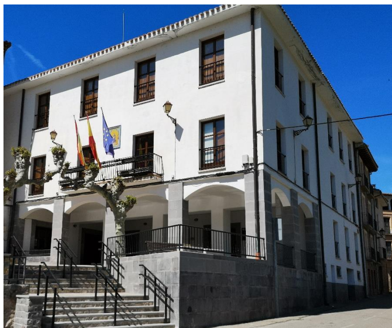
Figura 100. Edificio C/ Pedro Sagasta, 16. (Fotografía de la autora)
