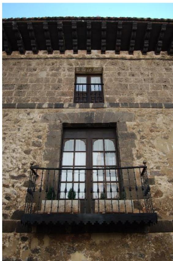
Figura 118. Edificio C/ San Martín, 4. Balcones con herrajes. (Fotografía de la autora)
