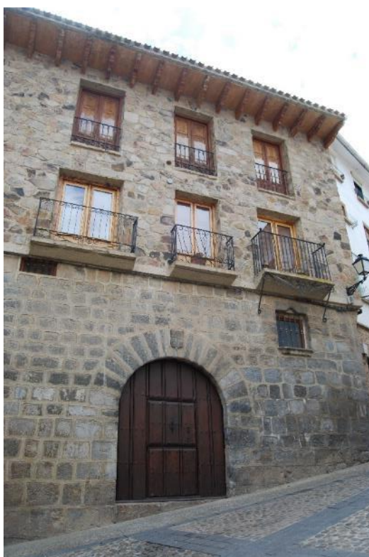
Figura 122. Edificio C/ Pedro Sagasta, 10. (Fotografía de la autora)
