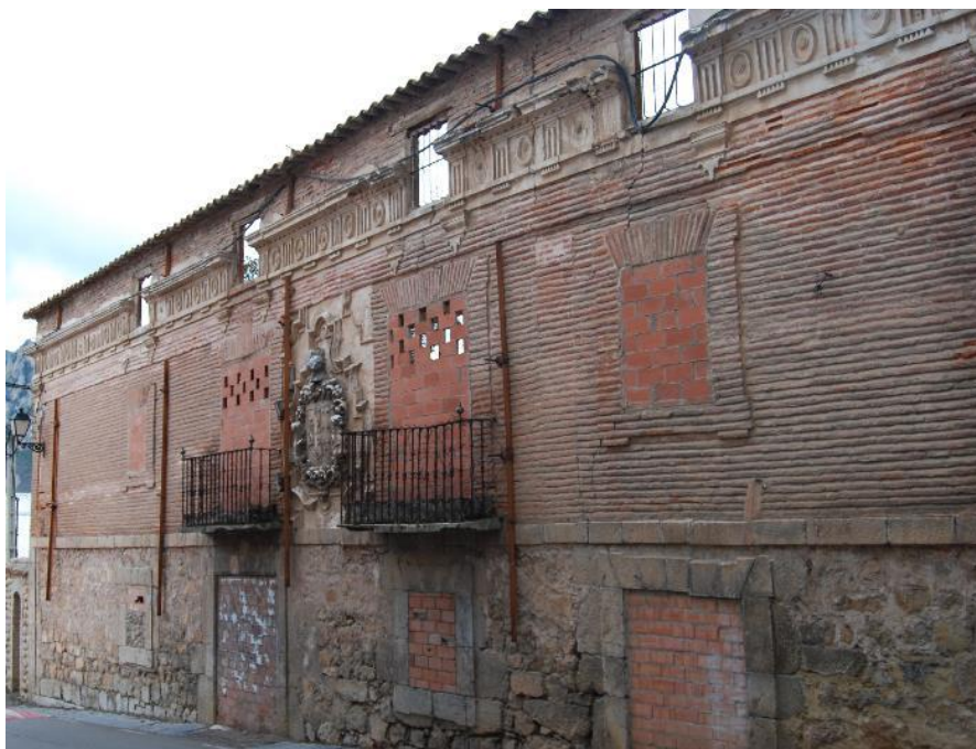
Figura 129. Edificio C/ Pedro Sagasta, 26. (Fotografía de la autora)
