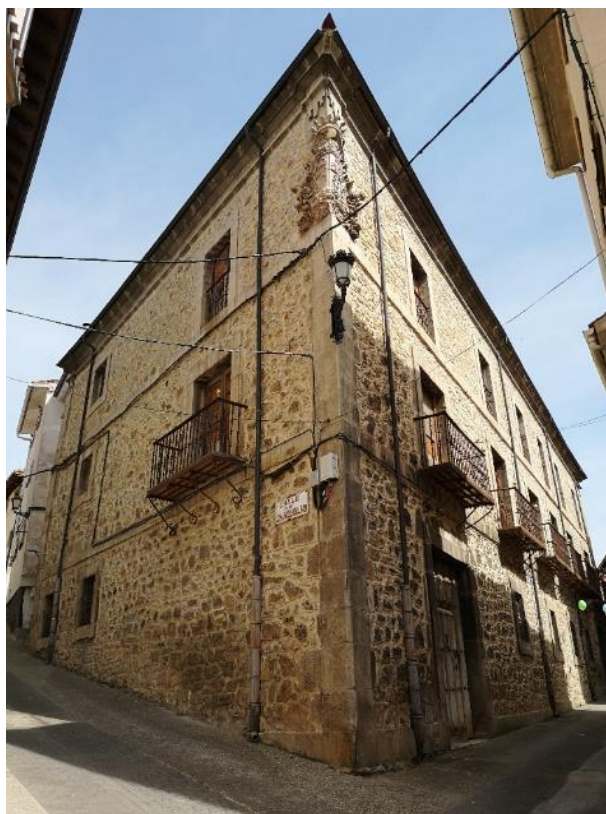
Figura 108. Edificio C/ Padre Cámara, 1. (Fotografía de la autora)
