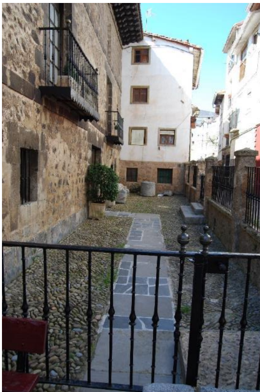
Figura 117. Edificio C/ San Martín, 4. Entrada. (Fotografía de la autora)
