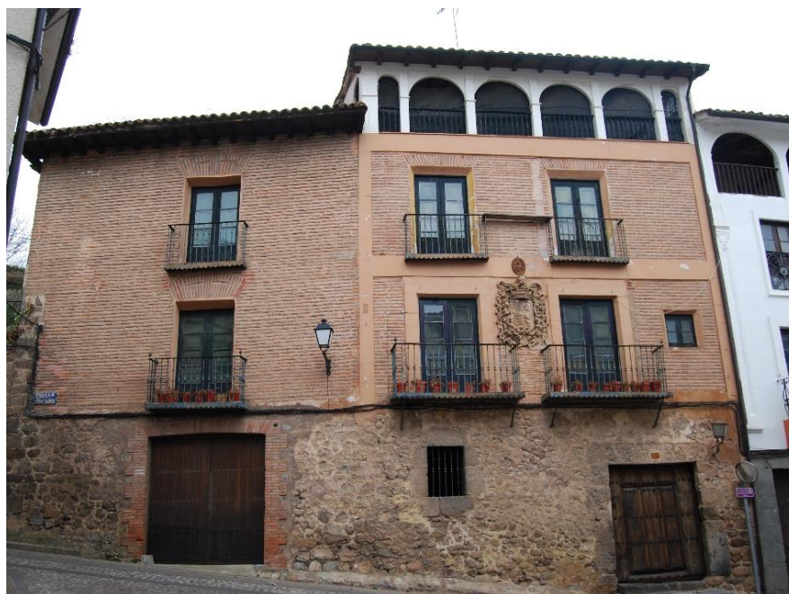
Figura 126. Edificio C/ Pedro Sagasta, 15. (Fotografía de la autora)
