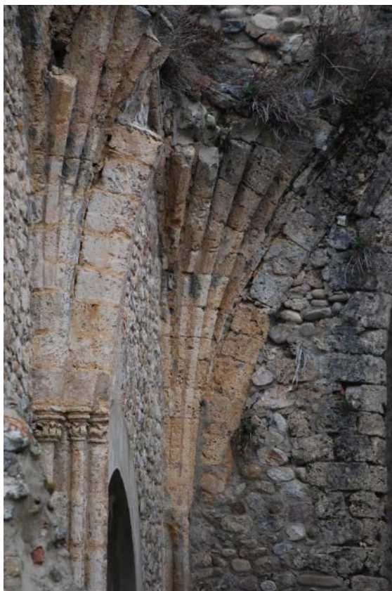
Figura 70. Iglesia de Las Vegas. Arranque de los arcos. (Fotografía de la autora)
