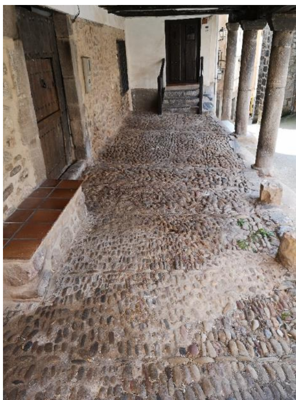
Figura 114. Edificio C/ Eusebio Nestares, 24. Soportales y columnas. (Fotografía de la autora)
