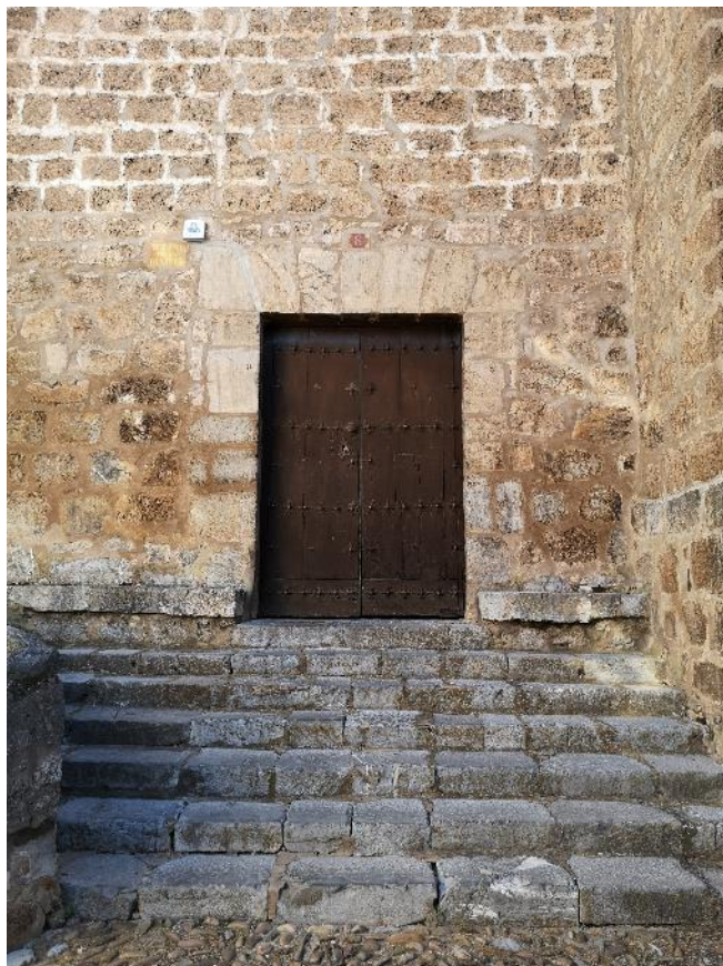
Figura 78. Iglesia de San Martín. Acceso sur. (Fotografía de la autora)
