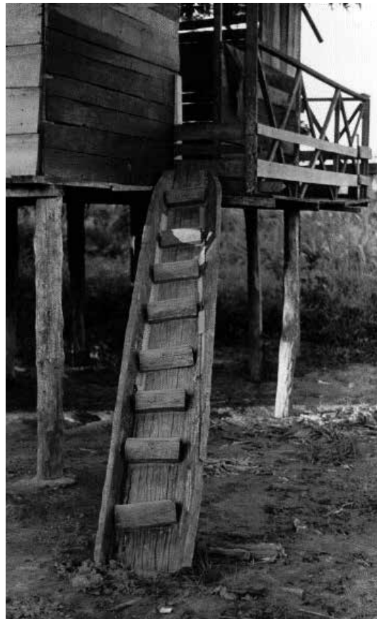
Foto 69 y Foto 70: Balastrés y escalera tipo tradicional en dos de las viviendas.
