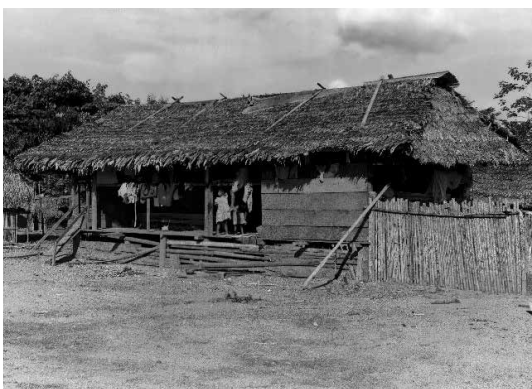
Foto 59: Vista interior del área cercada con caña-brava y gallinero. Foto 60: Vista de conjunto de casa de dos pisos con la cocina de un nivel.
