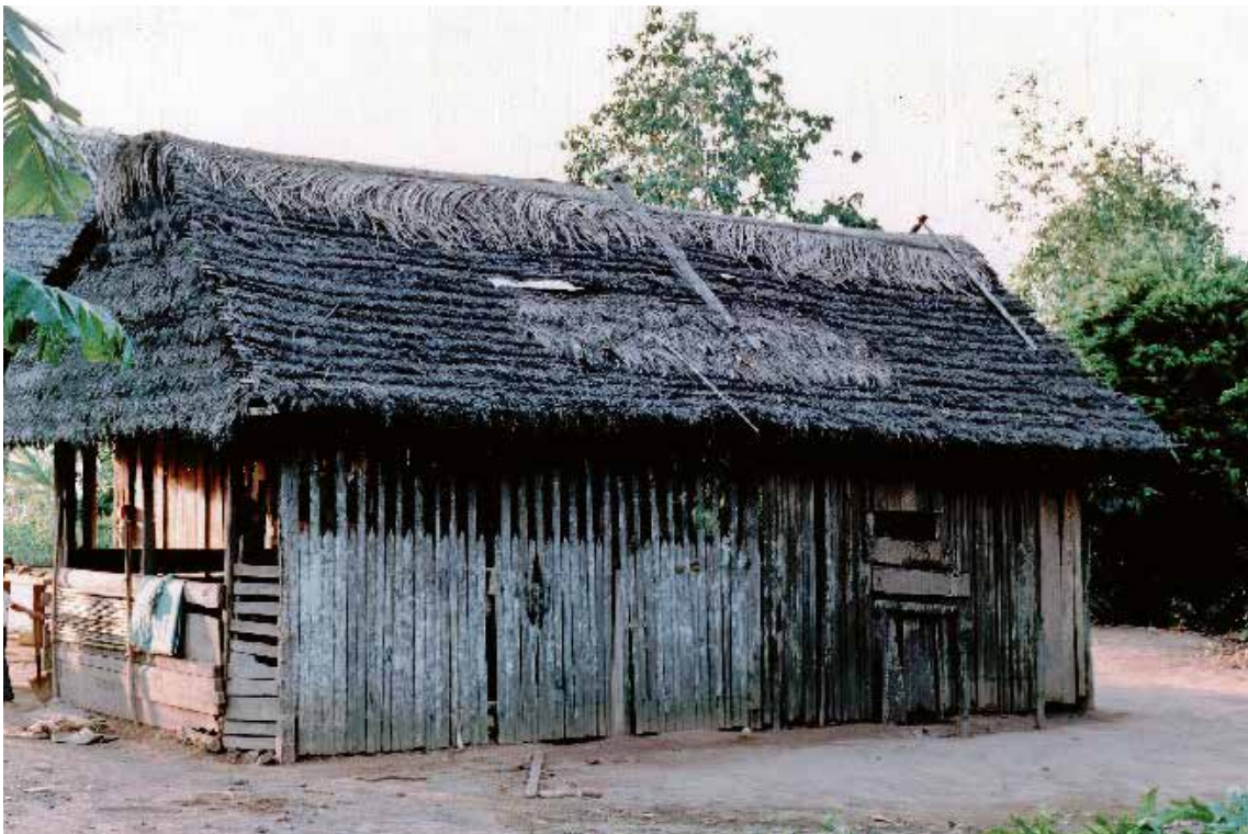
Foto 22: Vista general de la vivienda de dos volúmenes, tipología organizativa T-2.
