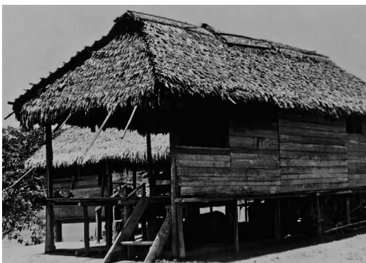
Foto 273: Vista lateral de la cocina. Foto 274: Vista de las fachadas lateral y frontal de la vivienda. Foto 275: Fachada posterior de la casa habitación. Foto 276: Vista lateral de la casa habitación. Foto 277: Espacio interior de la cocina con fogón a la derecha. Foto 278: Vista lateral del nuevo volumen construido próximo a la vivienda. Fuente: Olórtegui & Rummenhöller (1989).
