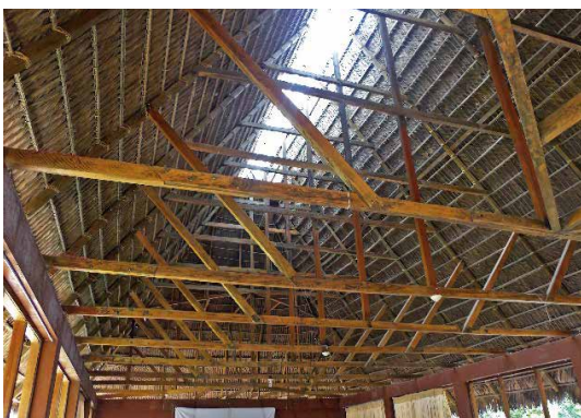
Foto 375, Foto 376 y Foto 377: Local comunal terminado e interior del techo con cumbreira translúcida. Foto 378: Frentes consolidados de edificaciones alrededor del espacio central con iluminación en base a paneles fotovoltaicos. Fuente: Autores (2019).
