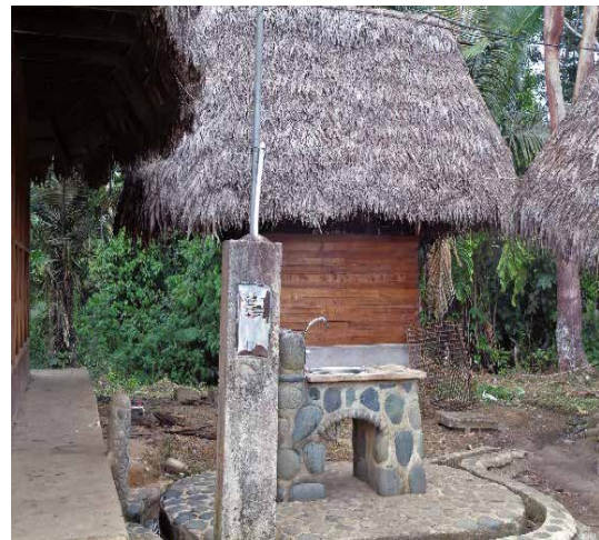
Foto 356 y Foto 357: Módulos con agua entubada y medidor de luz en cada unidad familiar. Fuente: Autores (2019).
