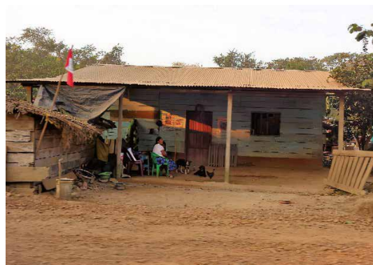
Foto 433 y Foto 434: Vivienda de dos niveles. Foto 435 y Foto 436: Viviendas de un solo nivel, la segunda con porche y local anexo. Fuente: Autores (2019).
