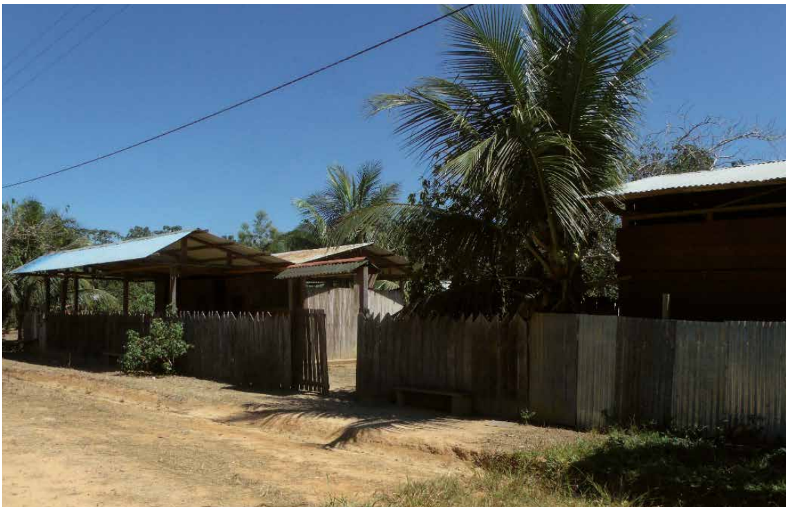
Foto 37: Carretera afirmada como eje central del asentamiento.
