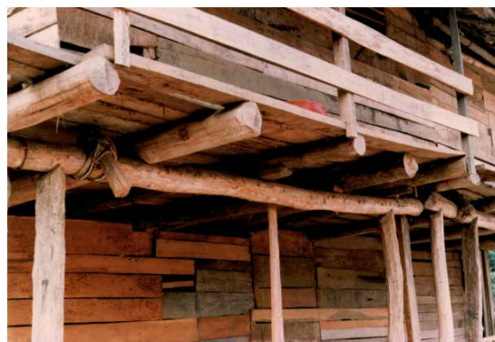
Foto 465 y Foto 466: Fachada posterior de Muestra 8 al sur. Se observa en el detalle del entrepiso el uso de madera rolliza y aserrada (1989). Fuente: Olórtegui & Rummehöller (1989).
