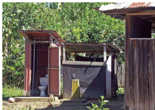
Foto 40 y Foto 41: Viviendas con paredes de lona plastificada negra y azul.
