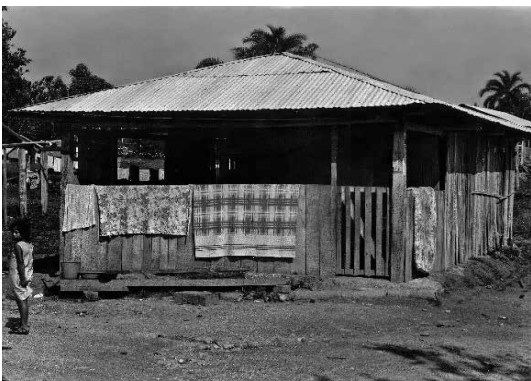
Foto 109: Núcleo con casa habitación y cocina.
