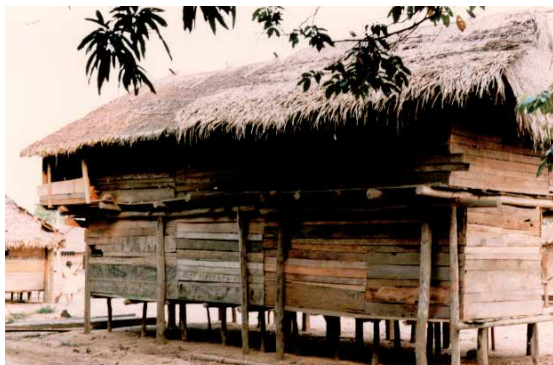
Foto 465 y Foto 466: Fachada posterior de Muestra 8 al sur. Se observa en el detalle del entrepiso el uso de madera rolliza y aserrada (1989). Fuente: Olórtegui & Rummehöller (1989).
