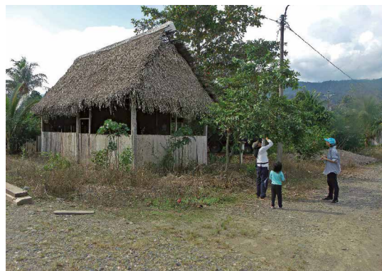
Foto 122, Foto 123, Foto 124, Foto 125, Foto 126, Foto 127 y Foto 128: Viviendas de la CN Shintuya, variadas en composición espacial, materialidad y sistemas constructivos. Fuente: Autores (2019).
