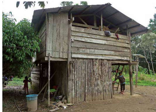
Foto 188 y Foto 189: Cocina y casa habitación con dos pisos y técnicas mixtas de construcción. Fuente: Autores (2019).
