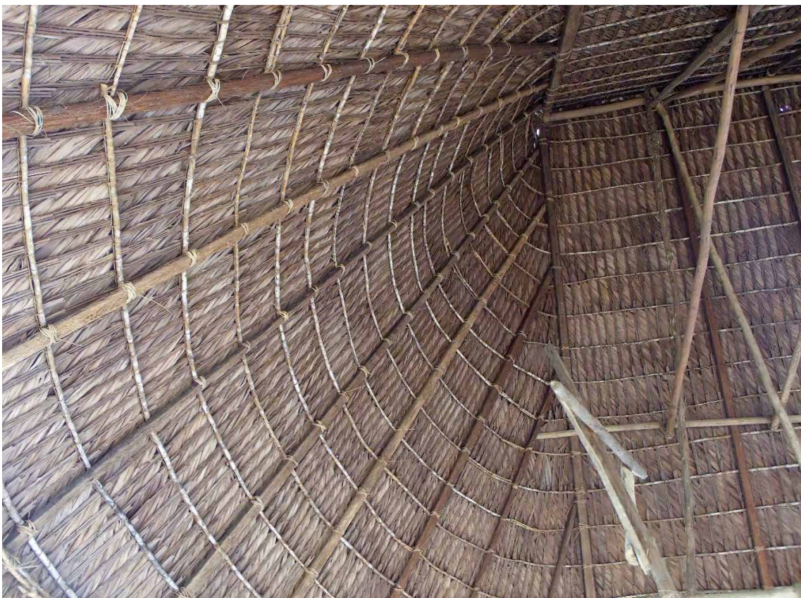
Foto 396: Techo con hojas tejidas y amarradas a la estructura, según el estilo Wachiperi. Fuente: Autores (2019).
