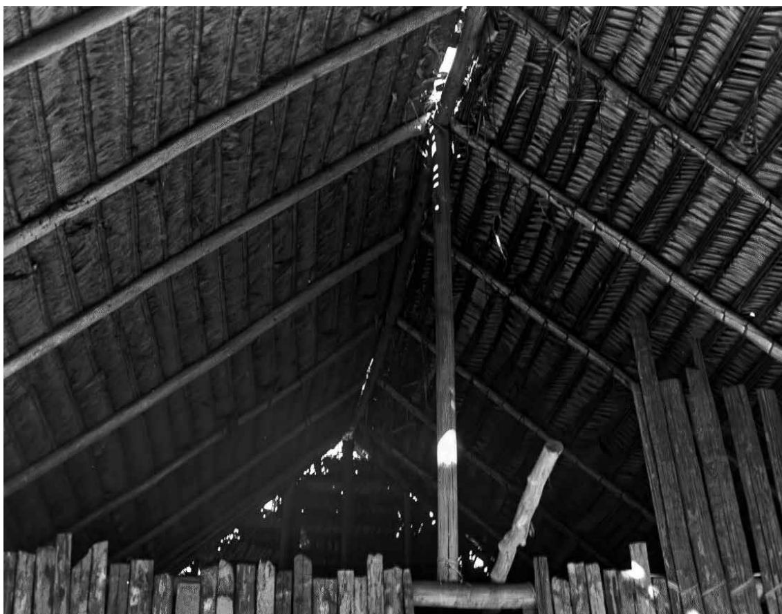
Foto 71: Detalle del techo. Se observa a la izquierda las crinejas de palmichi y a la derecha hojas de yarina . Fuente: Olórtegui & Rummenhöller (1989).
