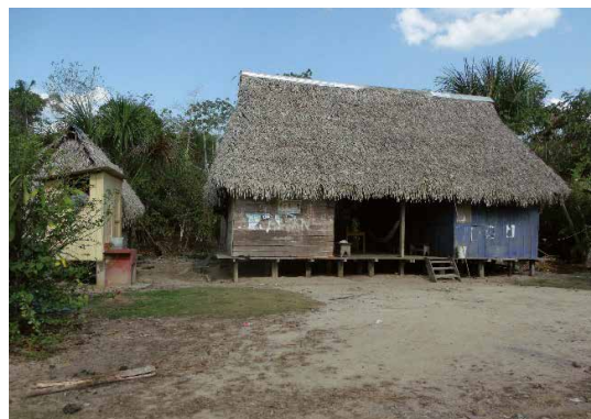
Foto 244, Foto 245, Foto 246 y Foto 247: Distintos núcleos de viviendas con servicios de agua y conexión de satélite. Observar el uso de piezas de calamina en las cumbreras de techos cubiertos con hojas de palmeras, así como los espacios cerrados y abiertos. Fuente: Autores (2019).
