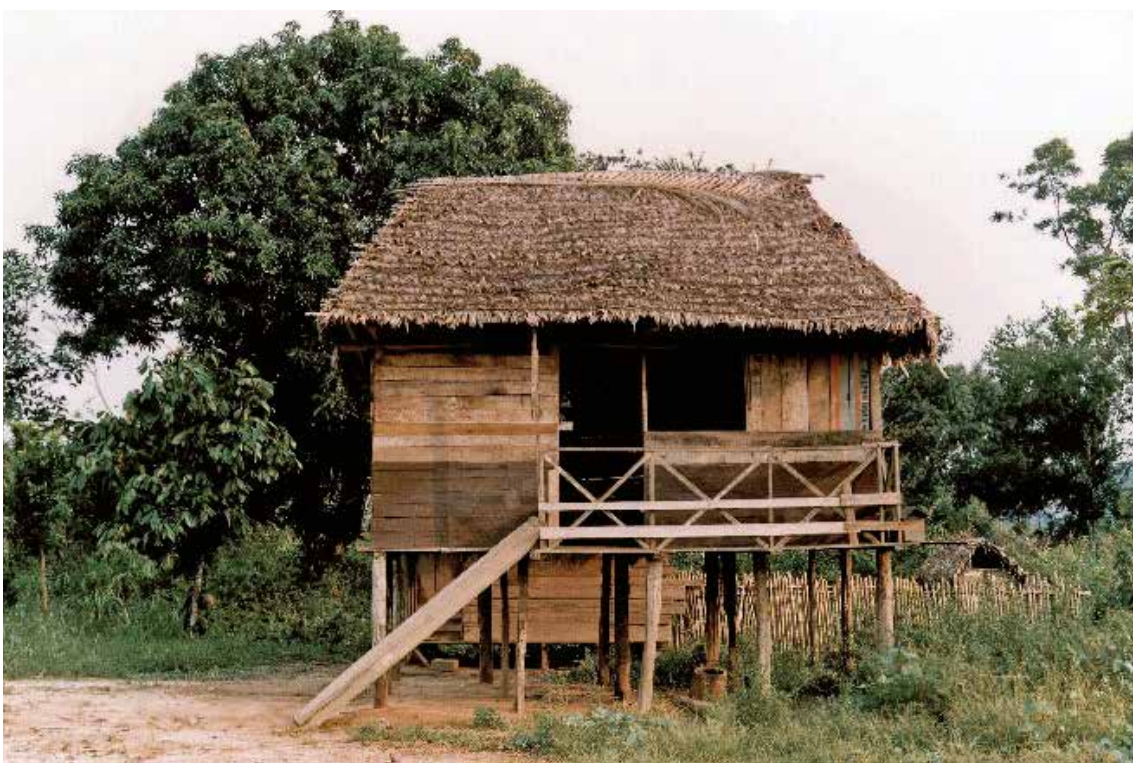
Foto 57: Lado suroeste y vista general de una vivienda de dos niveles.
