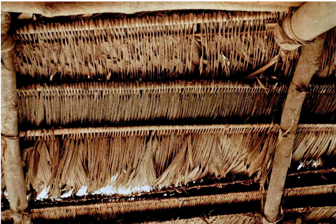
Foto 181: Detalle de unión de horcón destajado y viga transversal.
