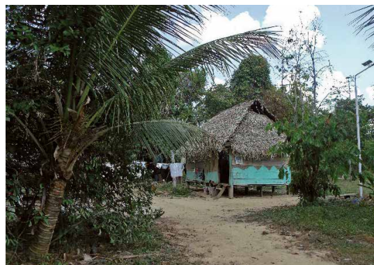
Foto 233: Baño con lavadero de ropa. Foto 234, Foto 235, Foto 236 y Foto 237: Espacios sociales con bancas en el exterior. Fuente: Autores (2019).
