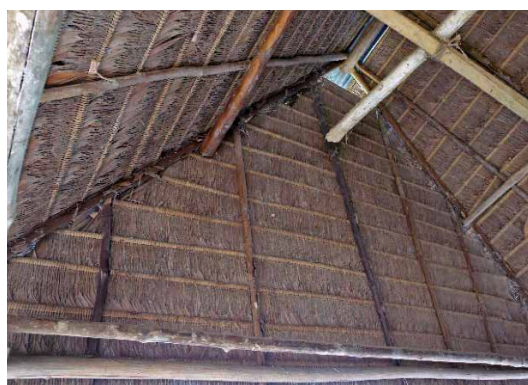
Foto 264 y Foto 265: Vivienda tradicional y vista interior del techo de hojas tejidas de palmichi . Fuente: Autores (2019).
