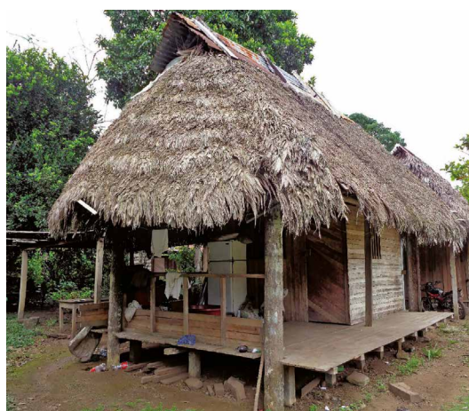
Foto 349: Vivienda con baranda frontal y piso elevado.
