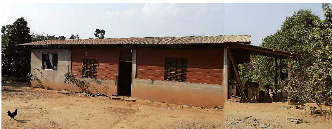
Foto 437 y Foto 438: Cocina tradicional en desuso y nueva casa habitación. Ambas del mismo propietario ubicadas a cierta distancia una de la otra en el mismo terreno. Fuente: Autores (2019).
