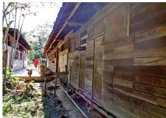
Foto 402 y Foto 403: Vistas del complejo de la misión abandonada desde 1980. Foto 404: Vistas laterales de las edificaciones de la misión. Foto 405, Foto 406 y Foto 407: Otras vistas de las edificaciones de la misión. Fuente: Autores (2019).
