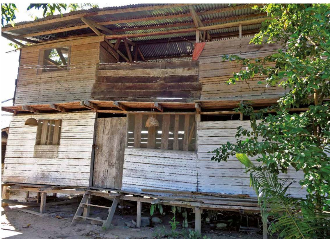
Foto 421: Vivienda de un solo volumen y nivel con piso elevado a poca altura del suelo. El área social con barandas y al lado el estacionamiento techado para motos.
