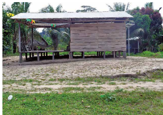
Foto 334: Única vivienda con piso de cemento y bordes de ladrillo.
