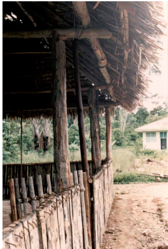
Foto 207: Estructura de una vivienda Yine en construcción. Foto 208 y Foto 209: Construcciones con sistema "antiguo" y "nuevo". Fuente: Olórtegui & Rummenhöller (1989).
