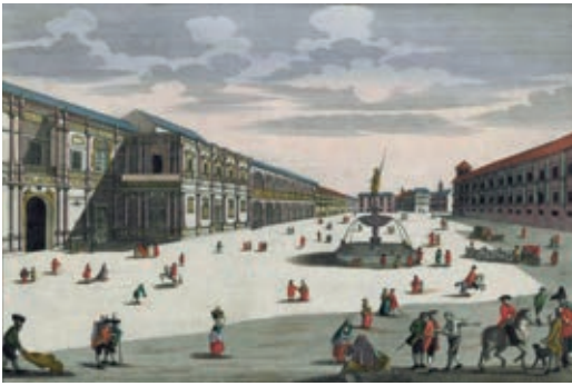
La grande Place de St. François, à Seville, vista óptica. Georg Balthasar Probst (c.1740). Bibliothèque Nationale de France, París
