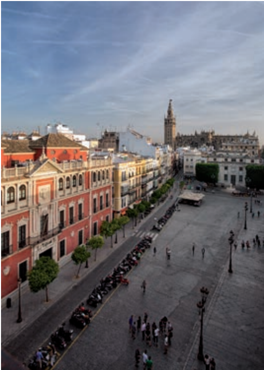
Vista General. El edificio, ya sede de la Fundación Cajasol ha recuperado el color de la fachada que tenía con la reforma de Aníbal González en 1924. Fotografía: Curro Cassillas (2015)
