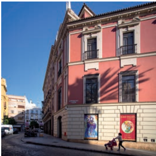
Vista actual de la fachada por las calles Bruna y Manuel Cortina o Entrecárceles. Fotografía: Curro Cassillas (2016)
