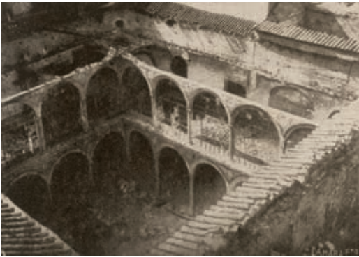
Un aspecto del patio principal de la Audiencia, después de extinguido el incendio.
