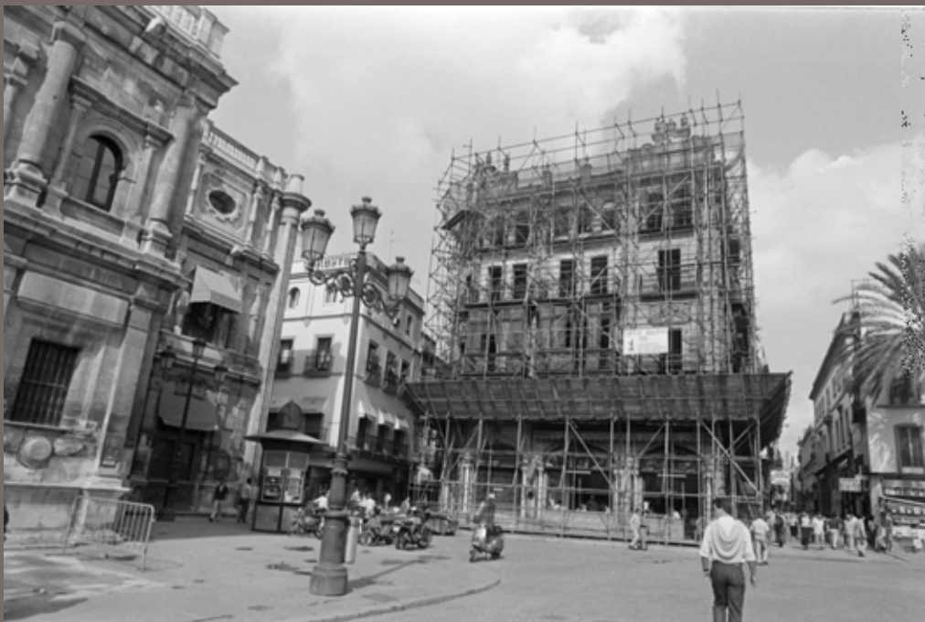
Francisco Macías. Restauración del edificio del Bar Laredo [1985] ICAS-SAHP. Fototeca Municipal de Sevilla. Archivo Alcaldía de Sevilla. Negativo plástico acetato 35 mm
