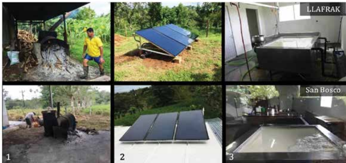
Figura 32. Comparativa del estado de la planta antes y después de la implementación de los sistemas solares.
