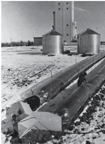
Figura 13. Colector solar de tubo de plástico. Inflado para calentar aire para secado de granos (Imagen: Besnier, 1980).
