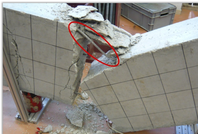
Figura A.17 Armadura longitudinal de una de las vigas de hormigón reforzadas a cortante con TRM utilizada como probeta de ensayo.
