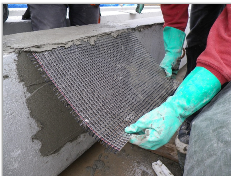
Figura 2.14 Instalación del TRM mediante técnica de aplicación húmeda.
