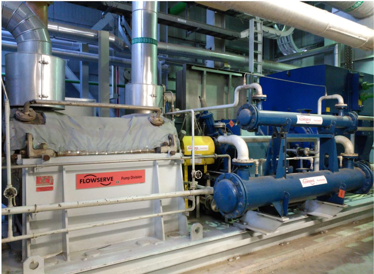
Figura 57. Foto de la disposición de una bomba de agua de alimentación de AP CCC (elaboración propia)
