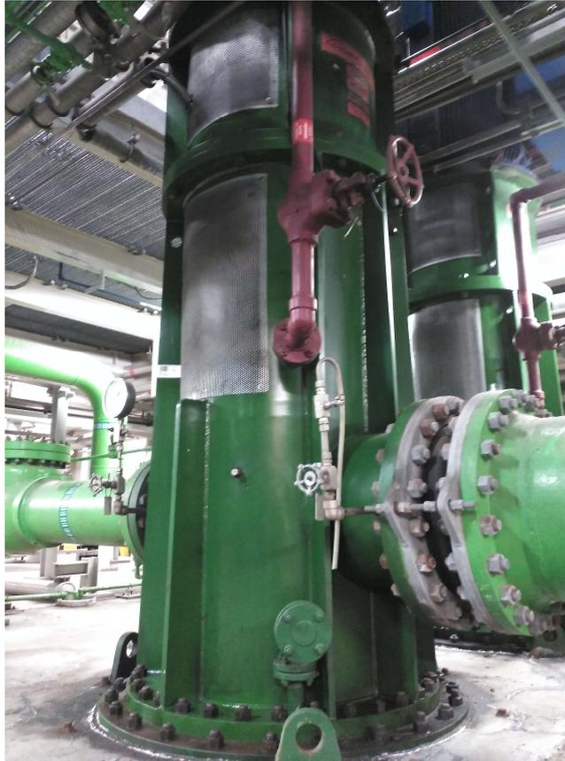
Figura 61. Foto de la disposición de una bomba de condensado CCC (elaboración propia)
