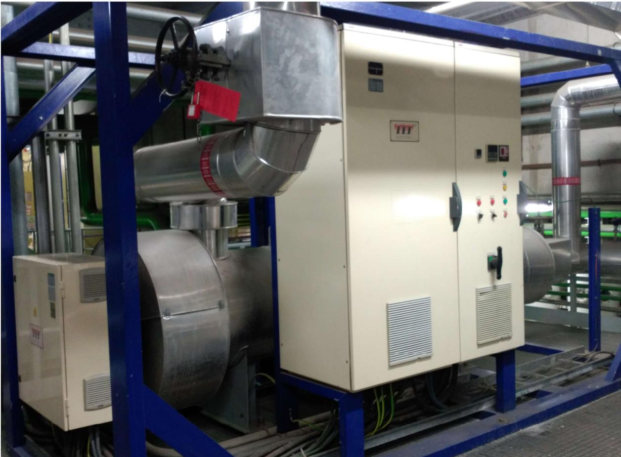
Figura 66. Foto de la disposición de una bomba “booster” CCC (elaboración propia)
