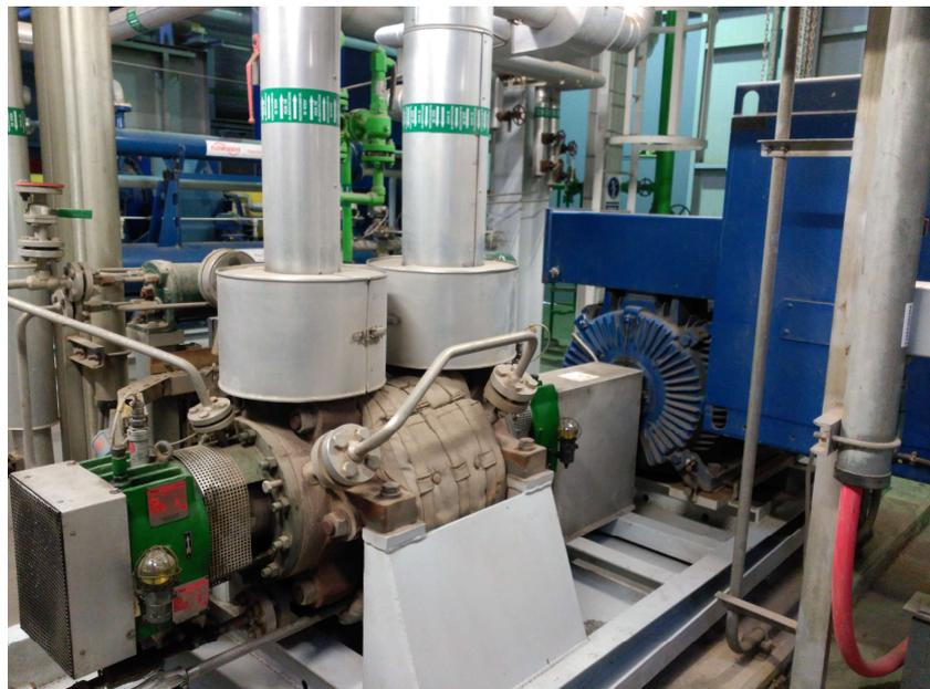
Figura 55. Foto de la disposición de una bomba de alimentación calderin de MP CCC (elaboración propia)
