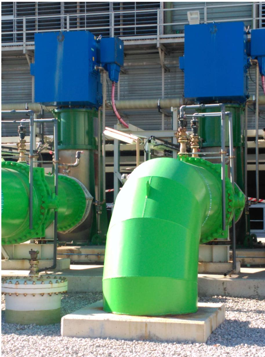
Figura 44. Foto de la disposición bomba de circulación CCC PdB (elaboración propia)
