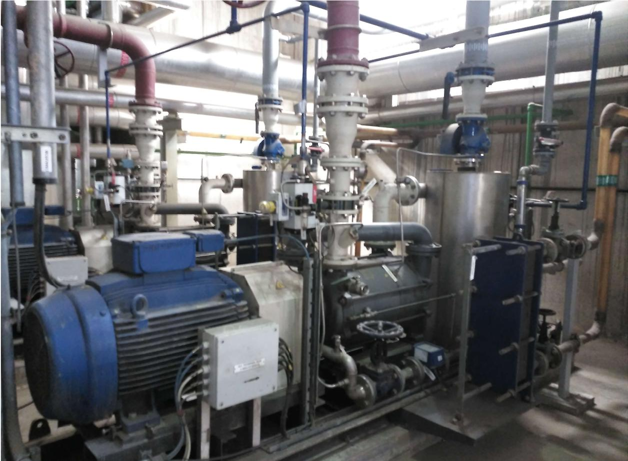
Figura 68. Foto de la disposición de una bomba de vacío CCC (elaboración propia)
