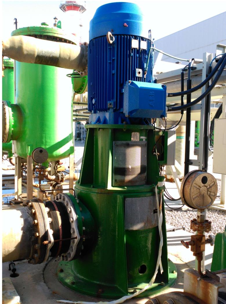
Figura 69. Foto de la disposición de una bomba de aporte CCC (elaboración propia)
