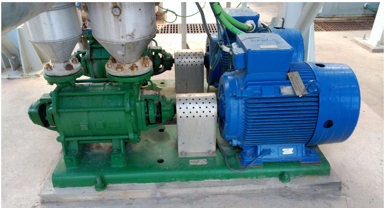
Figura 63. Foto de la disposición de una bomba de la caldera auxiliar CCC (elaboración propia)
