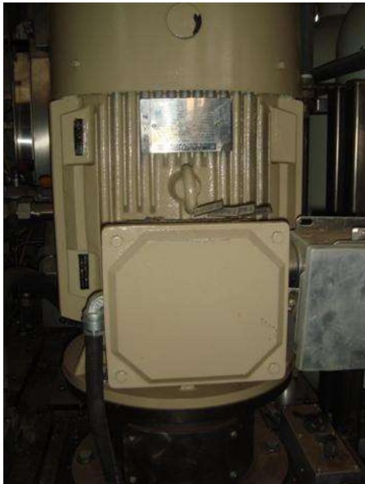
Figura 70. Foto de la disposición de una bomba de aceite hidráulico CCC (elaboración propia)
