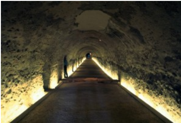
Intervención de Estanislao Roca en una bóveda del Circo
