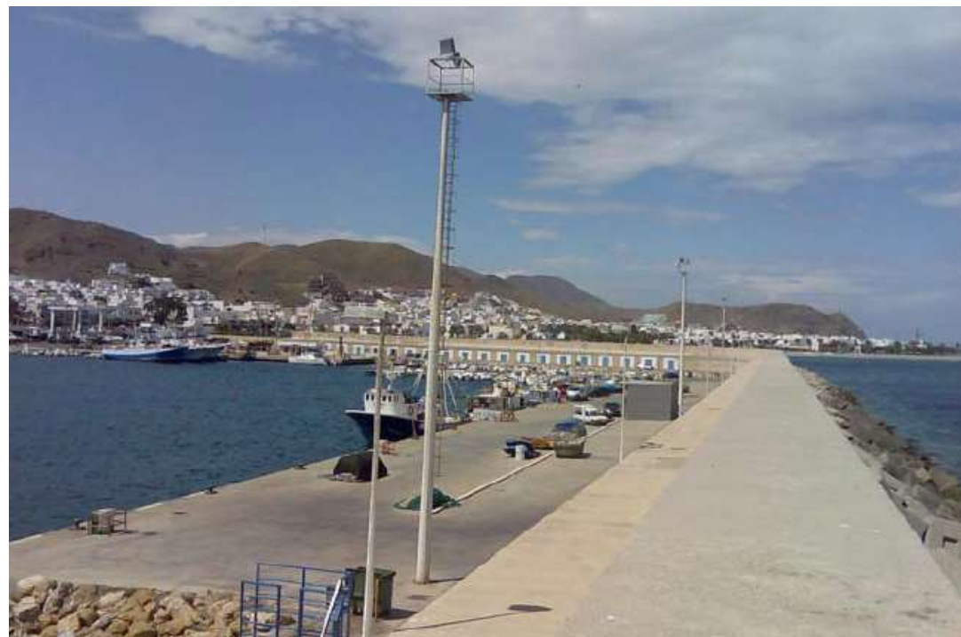
Figura 1. Vista del dique de abrigo con torretas de iluminación existentes
