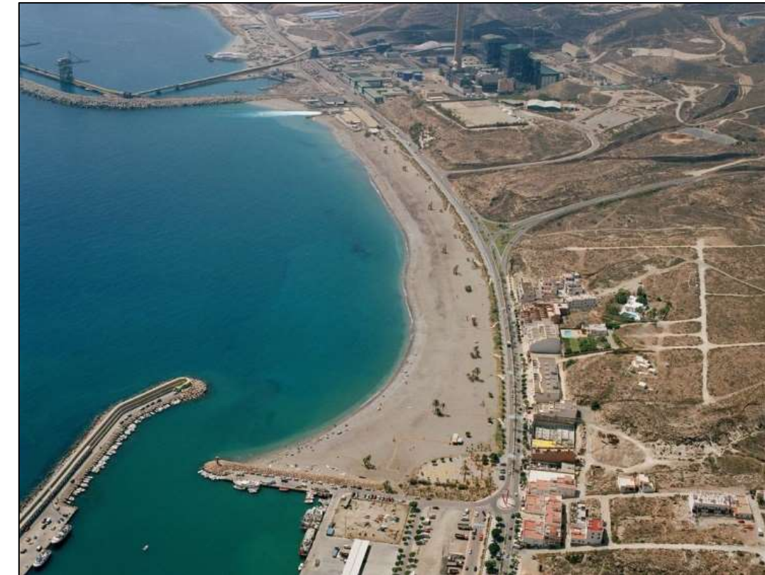
Figura 3. Playa de las Martinicas y dique de abrigo del puerto industrial.
