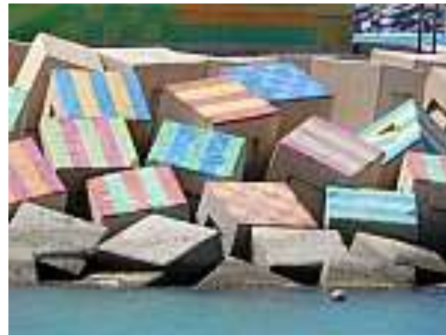
Figura 3. Detalle de los bloques de hormigón a la entrada del puerto de Carboneras
