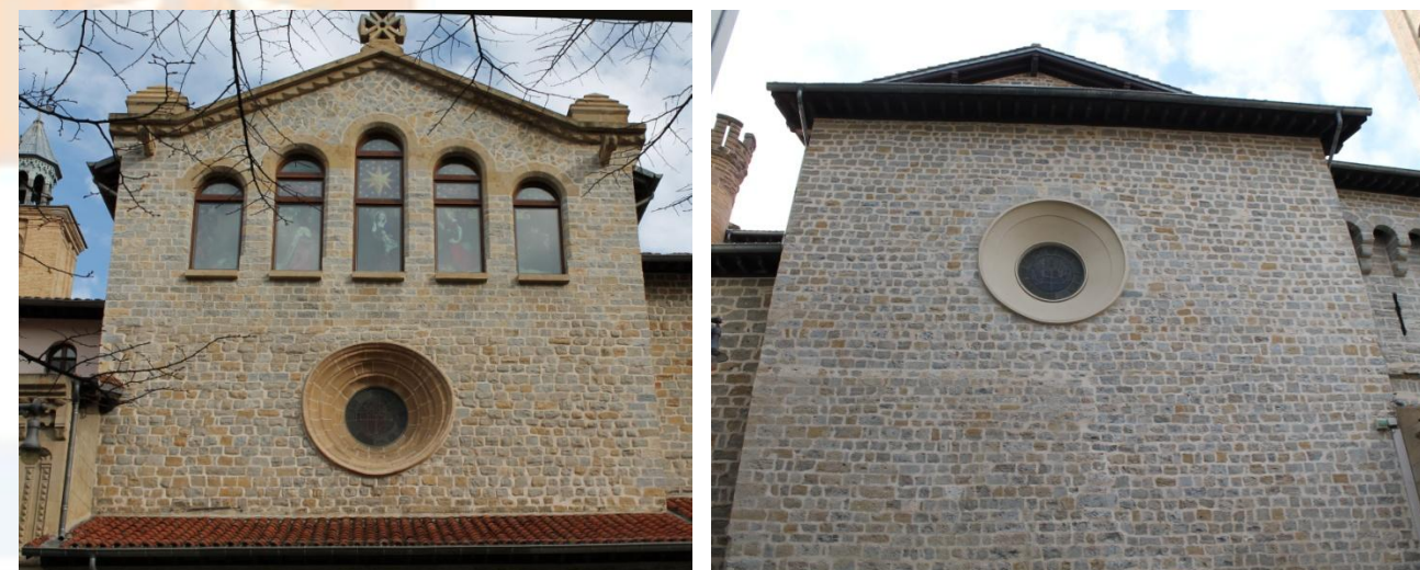
Img.72-73. Fachadas del crucero, izq. Paseo Sarasate; drcha. Plaza SN
