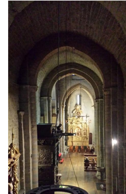
Img.40-41. Bóvedas de medio cañón (la de la Epístola a la izq. y la del Evangelio a la drcha.)
