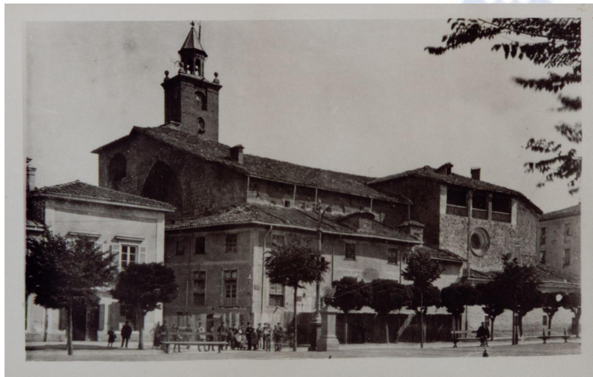
Img.17. Fotografía de 1889 desde el Paseo Sarasate. En ella observamos el vallado de las obras de la construcción de la casa parroquial.
