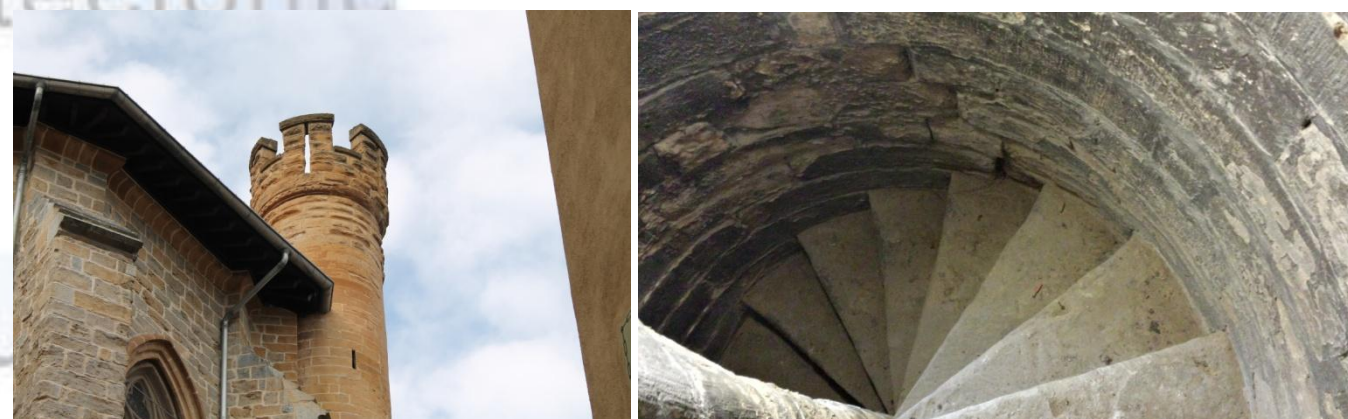
Img.76-77. Torre pequeña junto al ábside y sus escaleras de caracol
