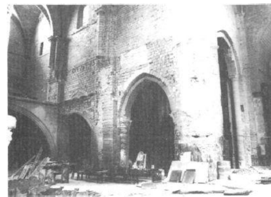
Img.30-31. Aquí se ve la nave lateral del Evangelio desde el crucero en la imagen de la izq. y desde la nave central en la de la izq., antes de ser restauradas. Se puede observar el mal estado de la fábrica. También se observa que el pilar semicircular que hoy en día va desde los cimientos hasta el comienzo de los nervios, comienza a dos tercios de la altura.
