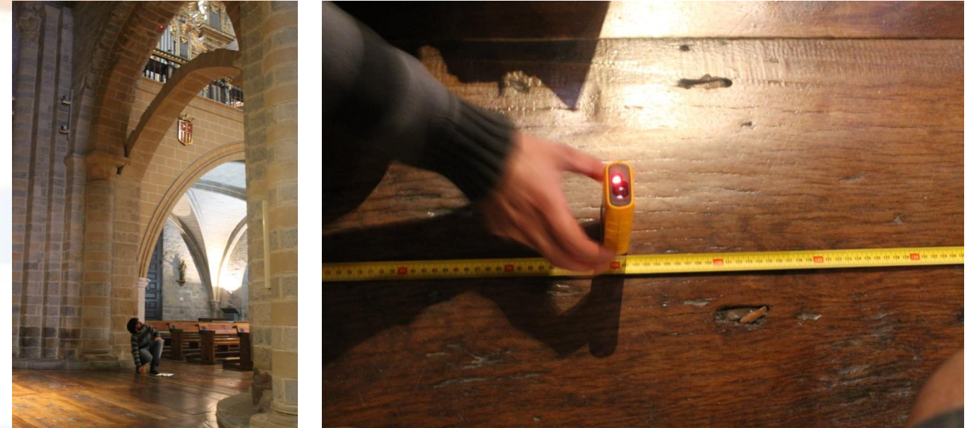
Img.119-120. Medición de la altura de los arcos cada cierta distancia
