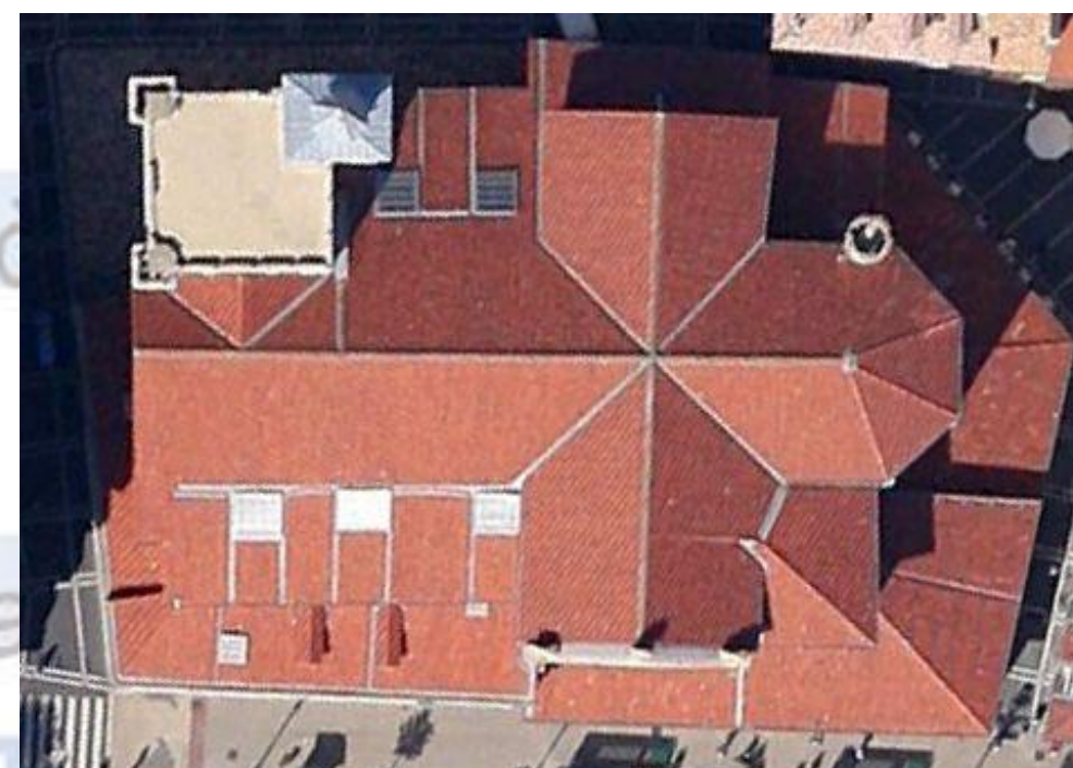
Img.58. Vista desde satélite de la cubierta, donde se aprecia el cuerpo de la iglesia
