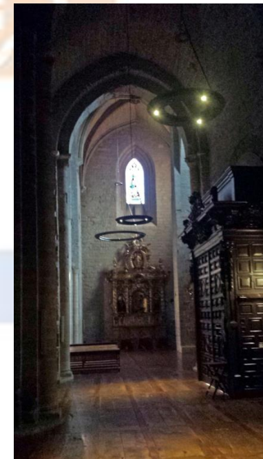
Img.40-41. Bóvedas de medio cañón (la de la Epístola a la izq. y la del Evangelio a la drcha.)
