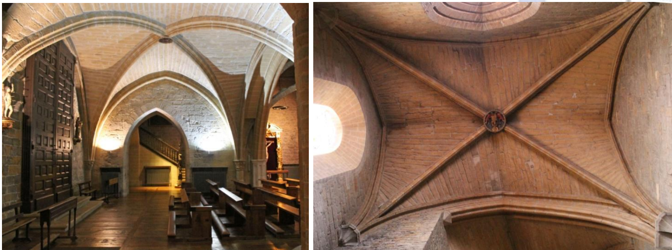
Img.36-37-38-39. Bóvedas de crucería (a la izq. nave central y sotocoro, a la drcha. capilla mayor y capilla de San Miguel)
