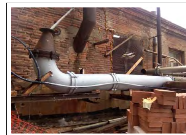
FOTO 8: TREBALLS ESTABILITZACIÓ AMIANT
