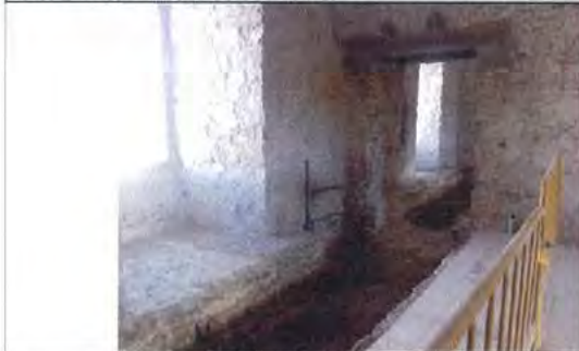
DESCRIPCIÓ: Rasa instal·lacions sala 29
