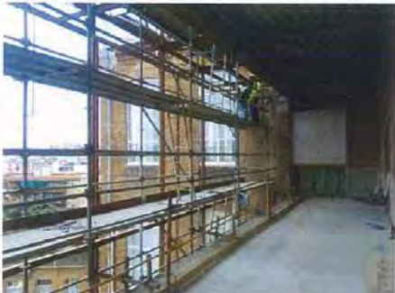
DESCRIPCIÓ: passera en coberta de xapa col.laborant. Sostre projectat amb perlita RF90
