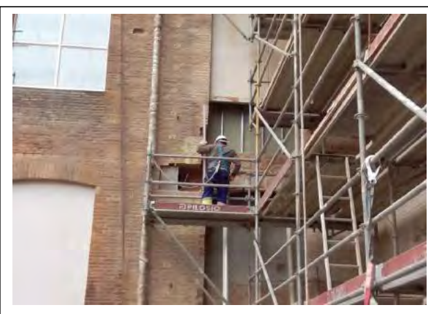
FOTO 5: TREBALLS DAU RECOLZAMENT HEB 500
