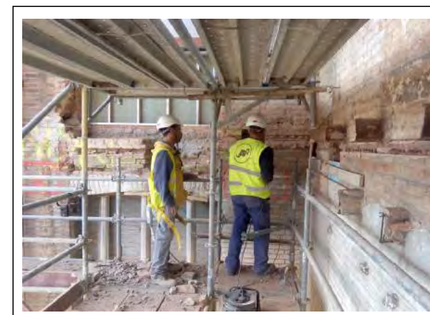
FOTO 4: TREBALLS DAUS RECOLZAMENT FAÇA NA
