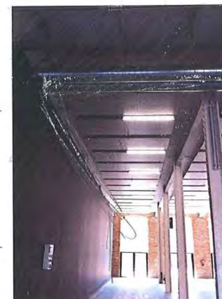
EXEMPLE SISTEMA DE MONTATGE DE PLAQUES I DE FLUORESCENTS
