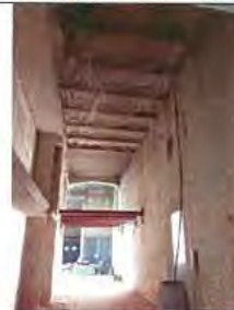
DESCRIPCIÓ: preparació escala metàl.lica planta 1
