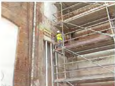
DESCRIPCIÓ: treballs repicat daus recolzament façana
