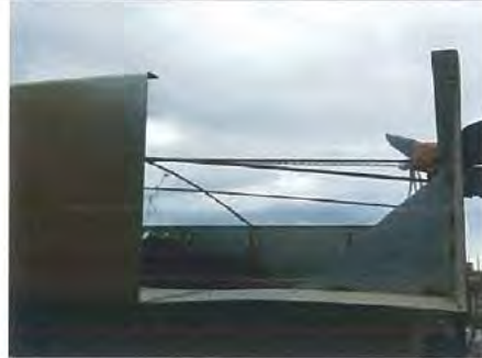
DESCRIPCIÓ: execució forjat col.laborant coberta
