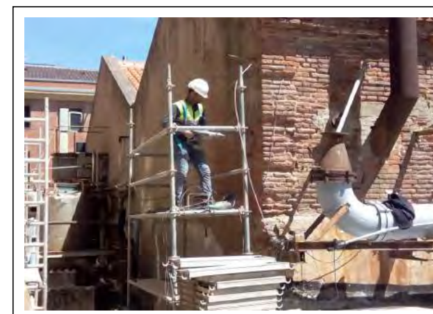
FOTO 8: TREBALLS DAUS SUPORT SALA CALDERES
