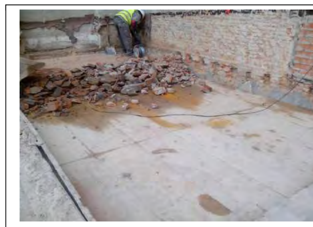
FOTO 7: TREBALLS D'ENDERROC I ENCOFRAT AL FORJAT DEL TERRAT PLANTA 1
