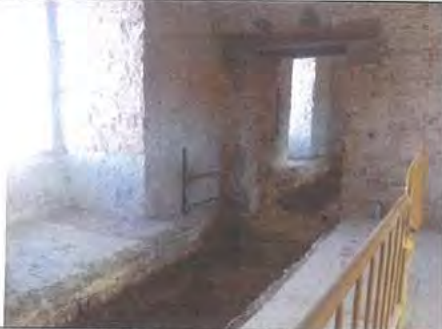
DESCRIPCIÓ: Rasa instal·lacions sala 29
