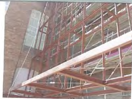
DESCRIPCIÓ: muntatge estructura
