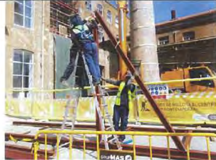
DESCRIPCIÓ: muntatge estructura a obra
