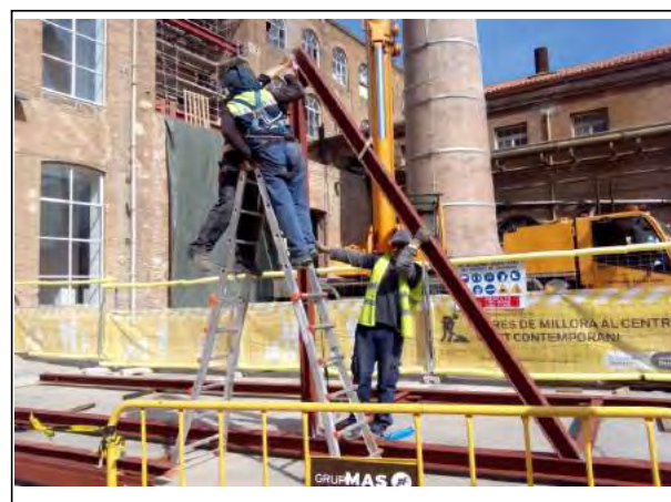
FOTO 6: MUNTATGE ESTRUCTURA METÀL.LICA DE TANCAMENT A OBRA
