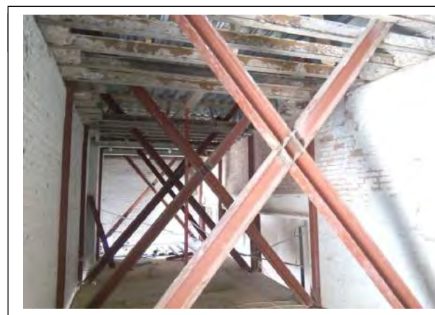
FOTO 3: ESTRUCTURA METÀL·LICA SOTA COBERTA
