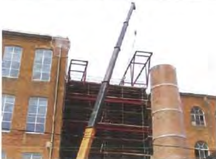
DESCRIPCIÓ: col.locació estructura de tancament
