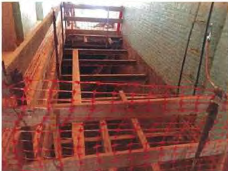
DESCRIPCIÓ: enderrocs forjat escala interior
