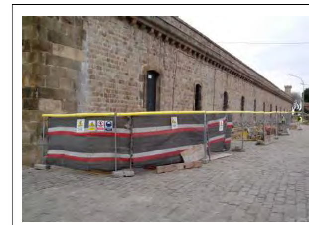
FOTO 8: ZONA DE LA NOVA ESCOMESSA DE LA ET
