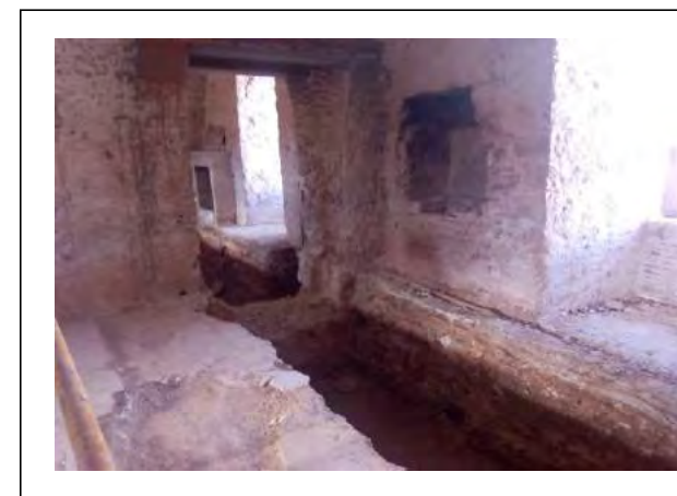
FOTO 4: RASA INSTAL·LACIONS SALA 30
