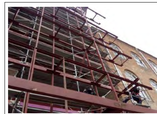
FOTO 4: TREBALLS SOLDADURA ESTRUCTURA
