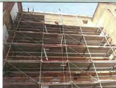
DESCRIPCIÓ: treballs col.locació bastida
