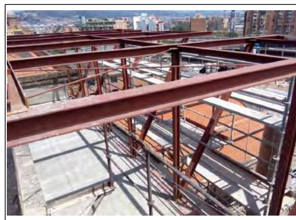
FOTO 2: ESTRUCTURA ZONA COBERTA
