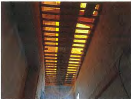
DESCRIPCIÓ: Enderroc forjat coberta escala interior
