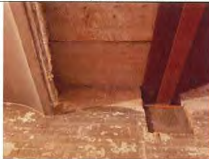
DESCRIPCIÓ: trobada forjat de revoltons + escala metàl·lica
