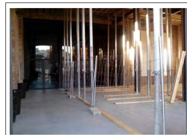
FOTO 4: APUNTALAMENT PORXO ENTRADA PRINCIPAL CAC + FC
