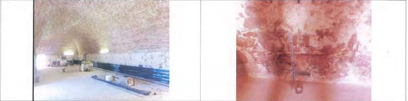
DESCRIPCIÓ: treballs instal·lacions a l'espai d'acollida
