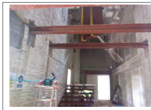
FOTO 7: TREBALLS MUNTATGE ESCALA INTERIOR METÀL·LICA
