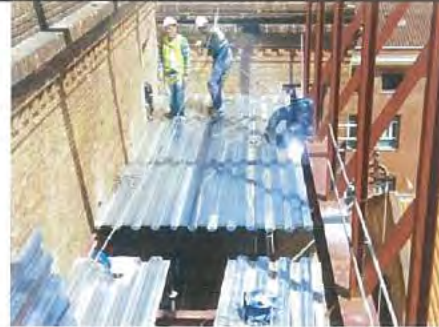
DESCRIPCIÓ: execució forjats col.laborants
