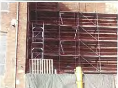
DESCRIPCIÓ: treballs muntatge bastida
