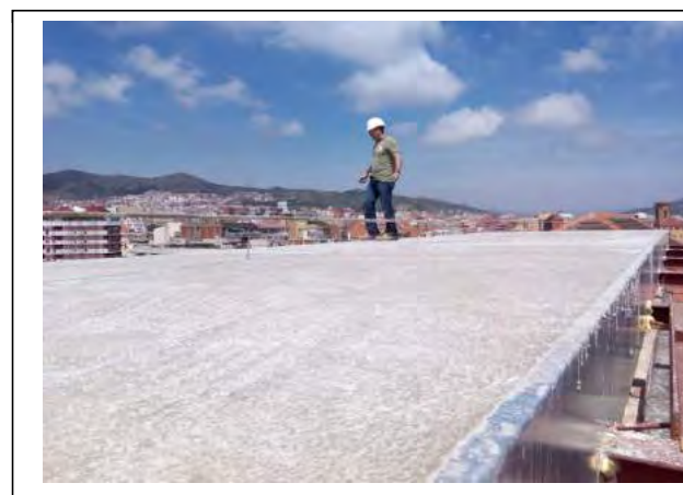
FOTO 7: FORMIGONAT COBERTA SOBRE ESCALA
