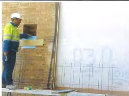
DESCRIPCIÓ: execució daus suport façana lateral
