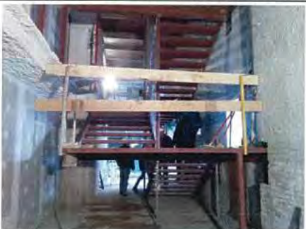
DESCRIPCIÓ: escala interior metàl·lica
