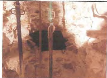
DESCRIPCIÓ: treballs obertura pas calabossos -cisterna
