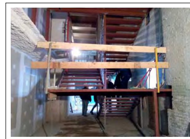
FOTO 8: ESCALA INTERIOR METÀL·LICA
