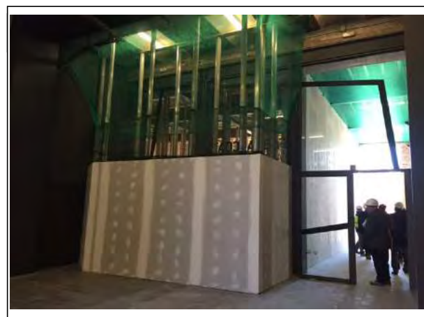
FOTO 2: TANCAMENT - ZONA D'OBRES A L'ESPAI DE LA FABRICA DE CREACIÓ
