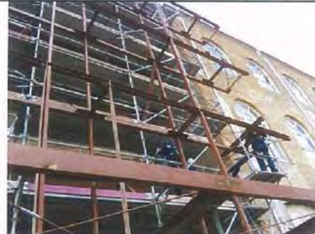
DESCRIPCIÓ: muntatge estructura
