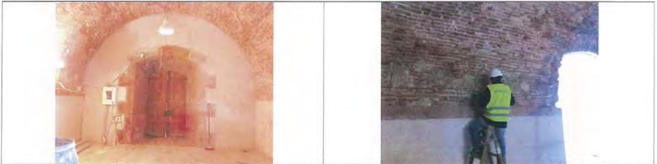
DESCRIPCIÓ: Acabats revestiments accés espai acollida
