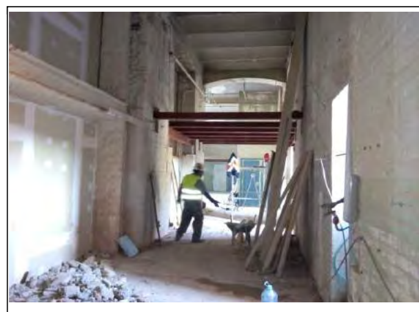
FOTO 6: COL.LOCACIÓ BIGUES ESCALA INTERIOR
