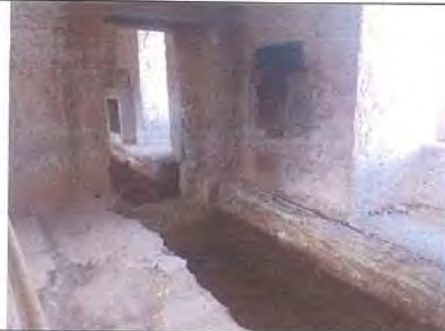
DESCRIPCIÓ: Rasa instal·lacions sala 30
