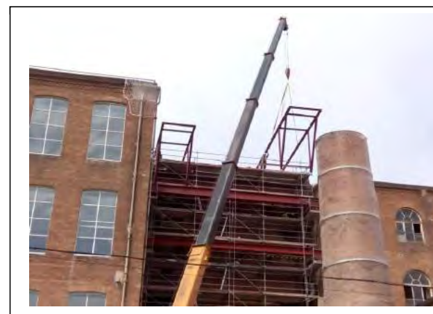
FOTO 7: TREBALLS COL.LOCACIÓ ESTRUCTURA METÀL.LICA DE TANCAMENT
