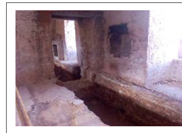
FOTO 4: RASA INSTAL·LACIONS SALA 30
