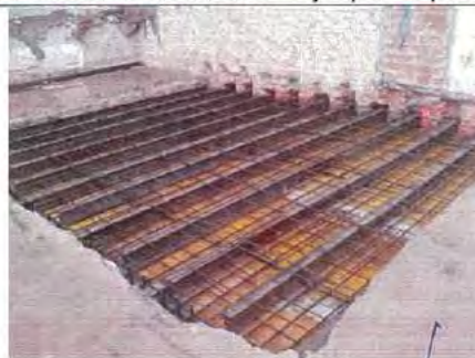
DESCRIPCIÓ: reconstrucció forjat planta primera
