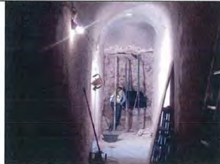
DESCRIPCIÓ: treballs obertura pas calabossos -cisterna
