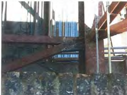
DESCRIPCIÓ: solució definitiva diagonals HEB 120 en planta tercera
