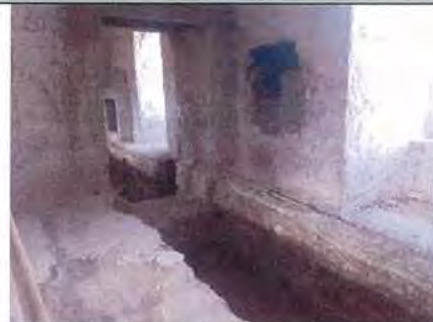
DESCRIPCIÓ: Rasa instal·lacions sala 30
