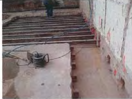
DESCRIPCIÓ: reconstrucció forjat planta primera
