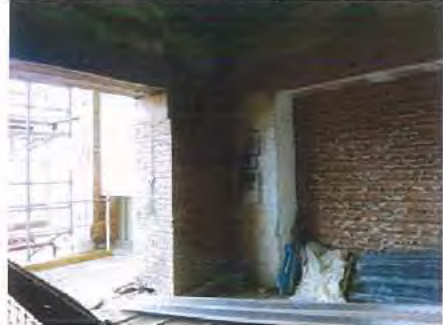
DESCRIPCIÓ: Espai interior zona escala metàl.lica. Acabat parament vertical de pladur 2.40m d'alçada. Pintura blanca
