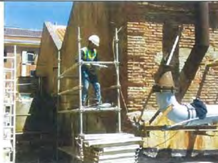
DESCRIPCIÓ: execució daus recolzament sala calderes
