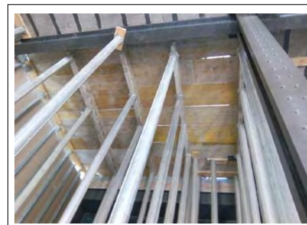
FOTO 4: APUNTALAMENT I ENCOFRAT PORXO ENTRADA PRINCIPAL CAC + FC
