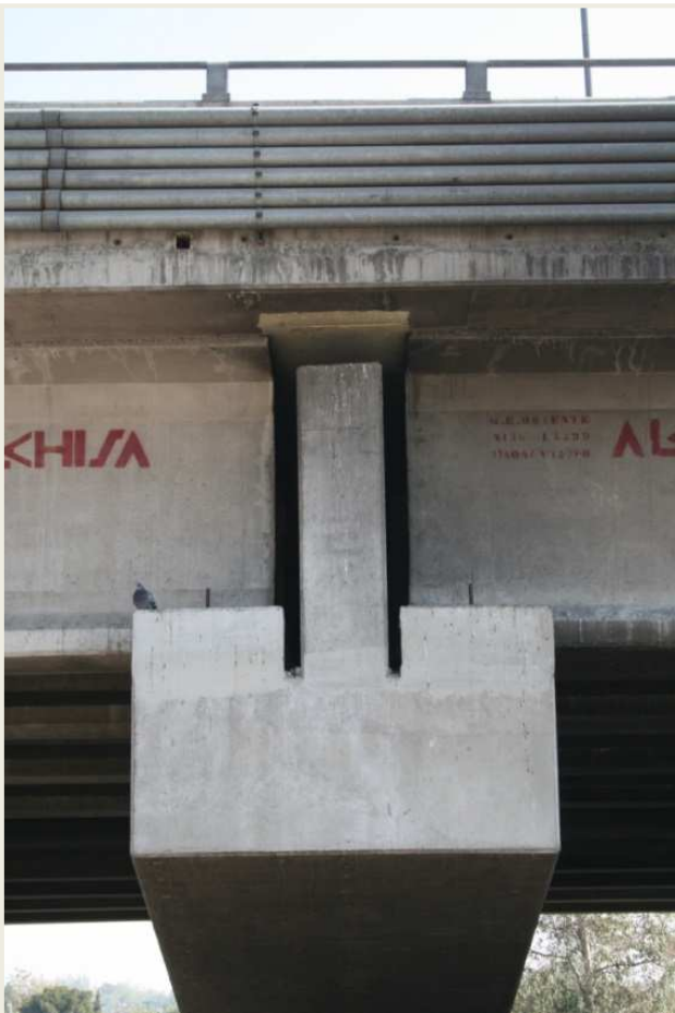
Figura 45: Topes longitudinal de hormigón armado. Fuente: Propia (29/04/2010).
