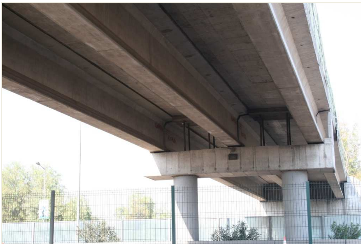
Figura 28: Vigas sin daños tras el terremoto. Fuente: Propia (28/04/2010).
