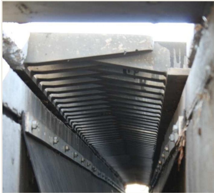
Figura 46: Junta metálica tipo “peine” entre estribo y tablero. Fuente: Propia (27/04/2010).
