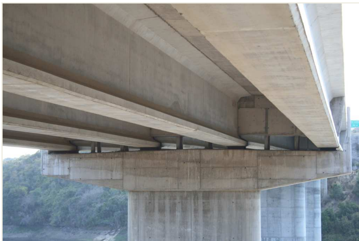
Figura 37: Barras de anclaje vertical en tablero con travesaño. Fuente: Propia (27/04/2010).
