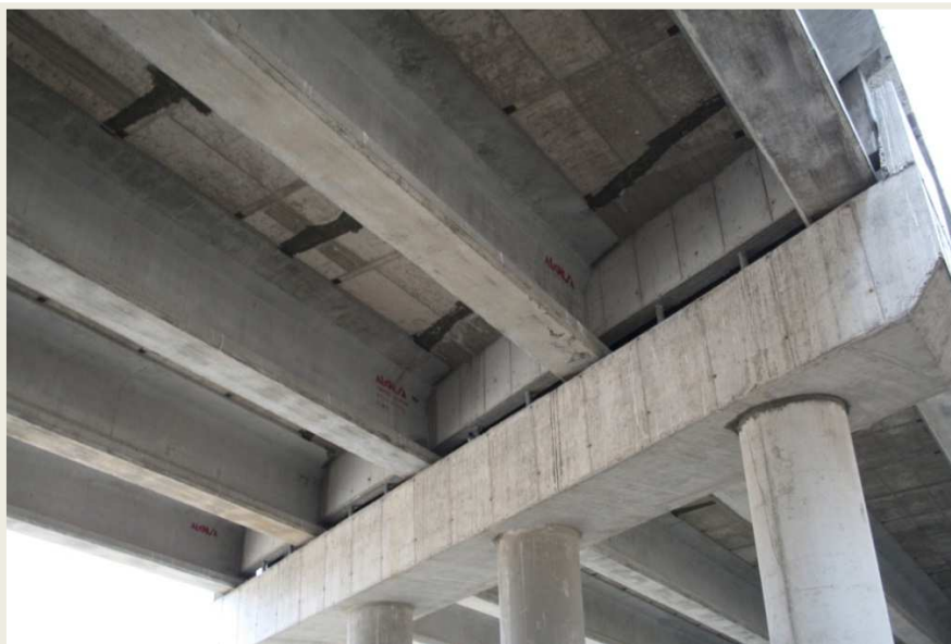
Figura 32: Travesaño de hormigón armado. Fuente: Propia (27/04/2010).
