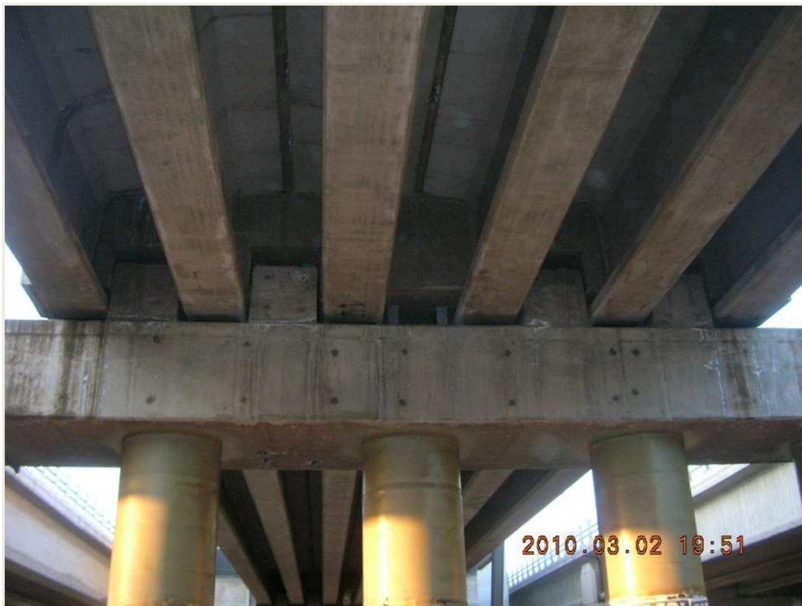
Figura 42: Topes transversales de hormigón en vigas centrales. Fuente: Propia (02/03/2010).
