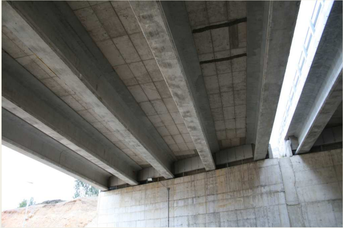
Figura 49: Tablero esviado, con travesaño y anclaje vertical con barras. Fuente: Propia (27/04/2010).
