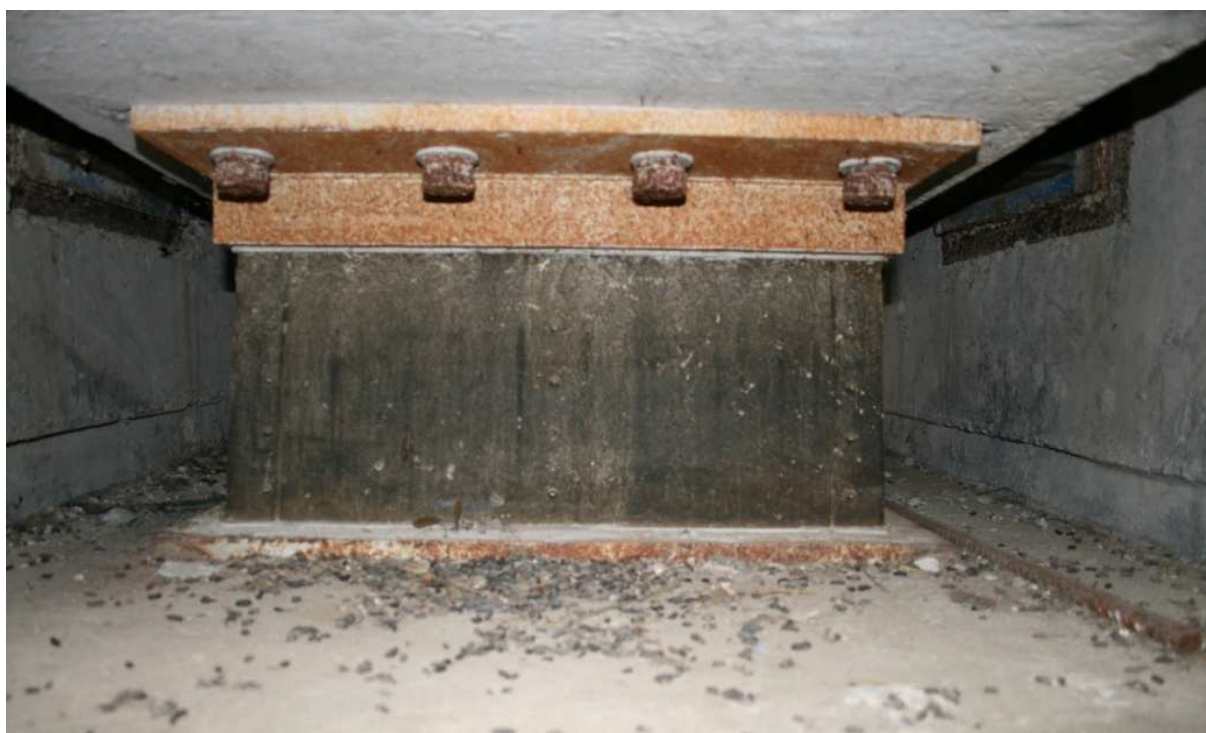
Figura 62: Aparato de apoyo anclado sin daño tras el terremoto. Fuente: Propia (27/04/2010)
