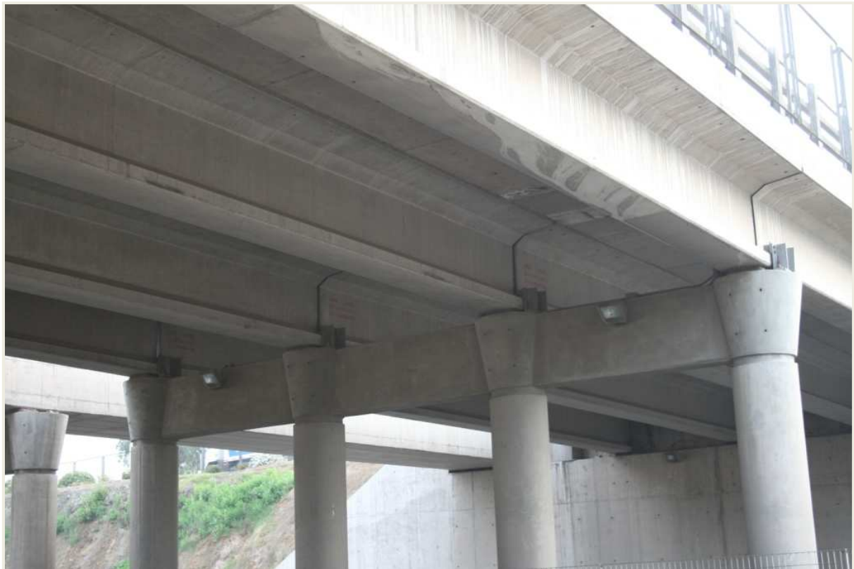
Figura 38: Anclaje vertical mediante angular metálico. Fuente: Propia (26/04/2010).
