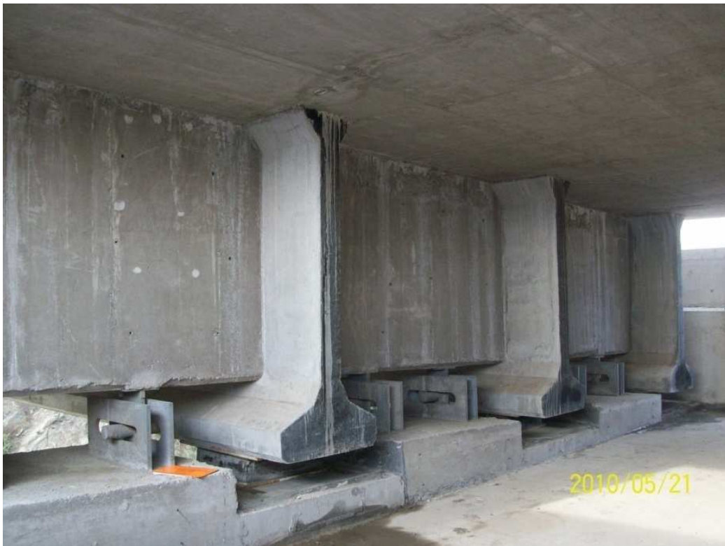
Figura 58: Topes longitudinales sin daño tras el terremoto. Fuente: PREANSA (21/05/2010)
