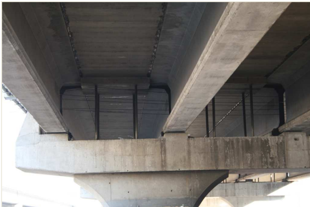
Figura 36: Barras de anclaje vertical en tablero sin travesaño. Fuente: Propia (28/04/2010).
