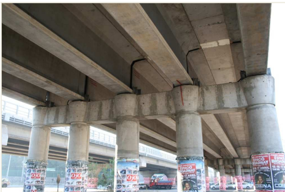
Figura 41: Angulares metálicos como topes transversales. Fuente: Propia (28/04/2010).
