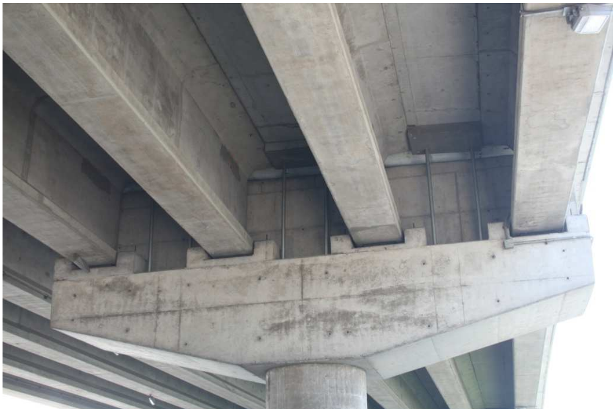
Figura 57: Topes transversales de hormigón sin daño tras el terremoto. Fuente: Propia (29/04/2010)
