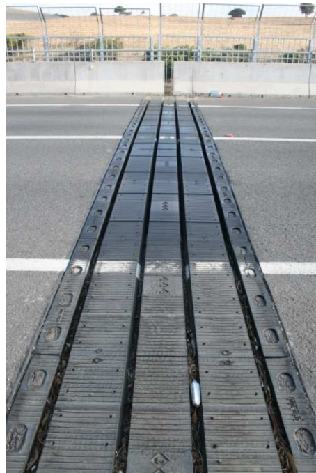
Figura 47: Junta elastomérica. Fuente: Propia (27/04/2010).
