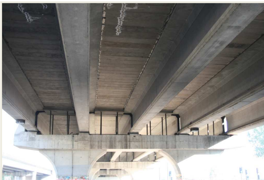
Figura 33: Tablero con vigas sin travesaño. Fuente: Propia (28/04/2010).
