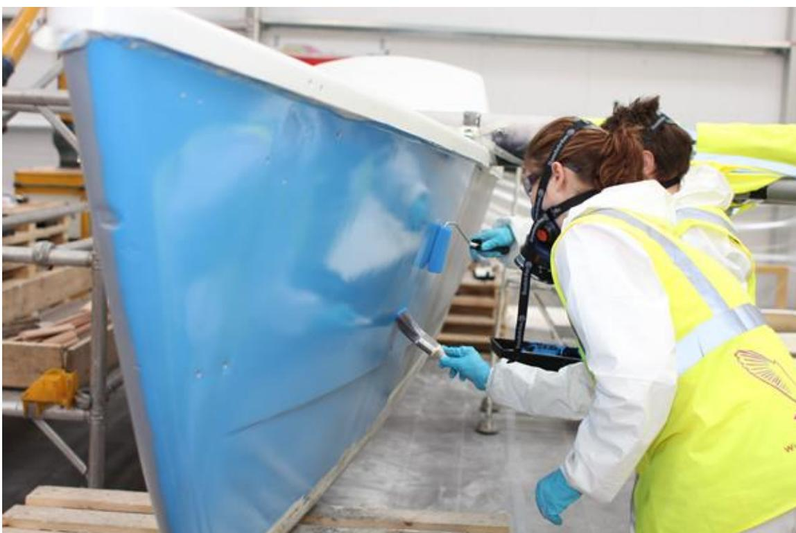
Figura 29. Pintado de un casco mediante brocha y rodillo – [www.yachtpaint.com](http://www.yachtpaint.com)
