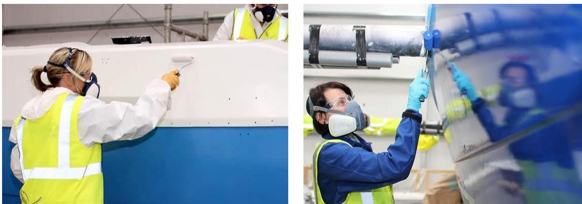
Figura 33. El uso del rodillo es particularmente útil en el pintado de superficies amplias y planas – [www.yatchpaint.com](http://www.yatchpaint.com)
