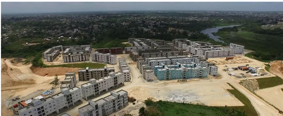
Ilustración 20: Etapa de construcción Nuevo Asentamiento La Barquita, Santo Domingo. Fuente: Acento Diario
