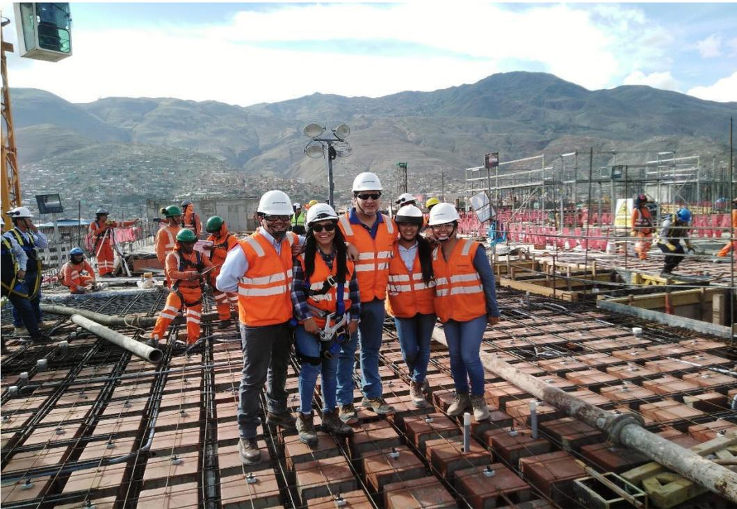
Foto 25. Verificación del acero y dados de concreto, previo al vaciado de concreto.
