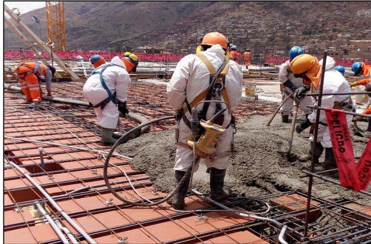
Nota: Proceso de vaciado de losa aligerada usando traje tivatek.
