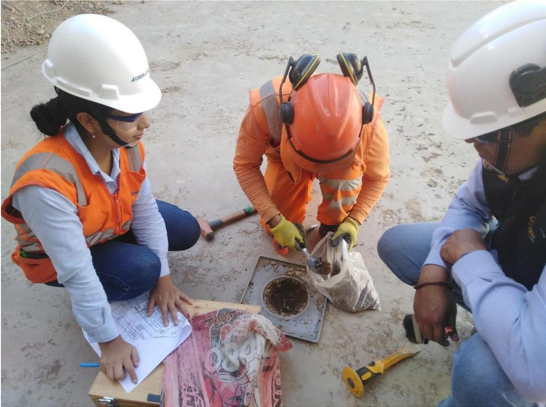
Foto 18. Control del ensayo de densidad para poder realizar vaciados posteriormente
