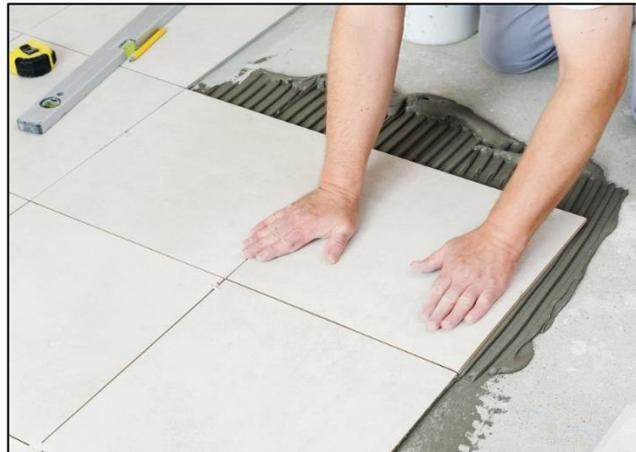
Nota: Instalación baldosas con pegamento y según modulación.. Tomada de: Truini, 2017.
