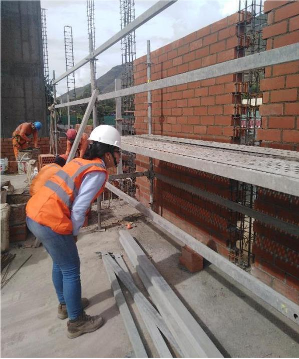
Foto 24. Control de calidad para el vaciado de las columnas
