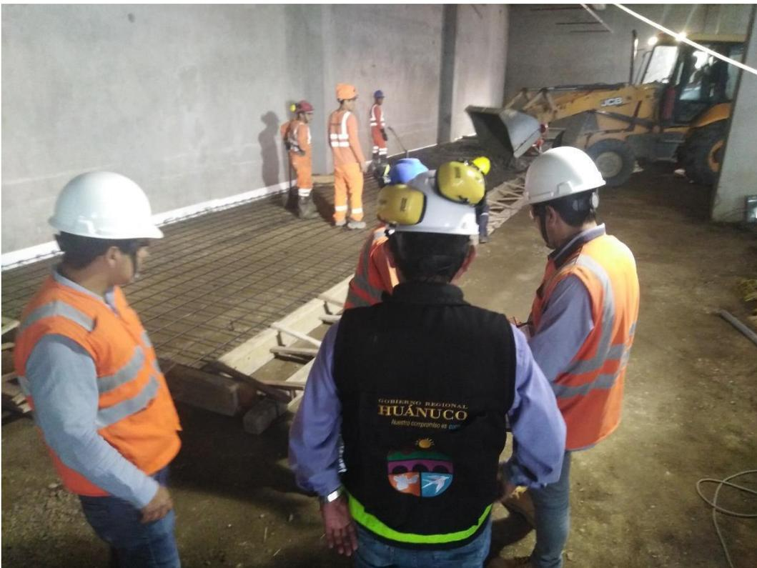
Foto 15. Control de calidad en el vaciado de losa
