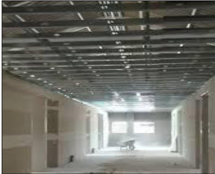
Nota: Instalación de dinteles y drywall. Tomada de: Ramirez, 2014.
