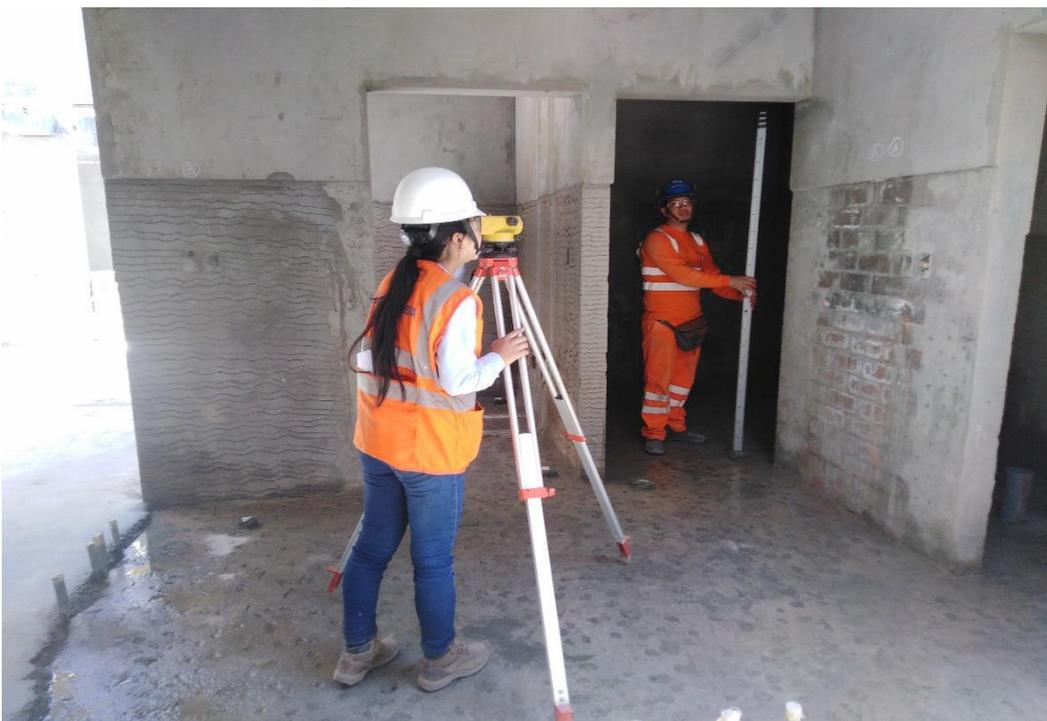
Foto 23. Control de calidad para el vaciado de contrapisos
