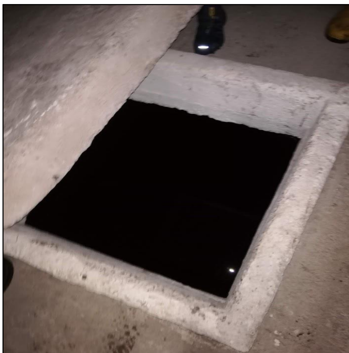
Tanque de distribución
