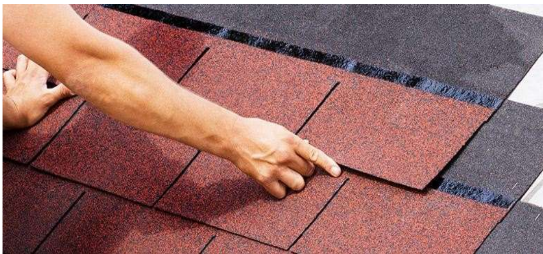
Figura N°40: Impermeabilización en losas aligeradas – Teja asfáltica
