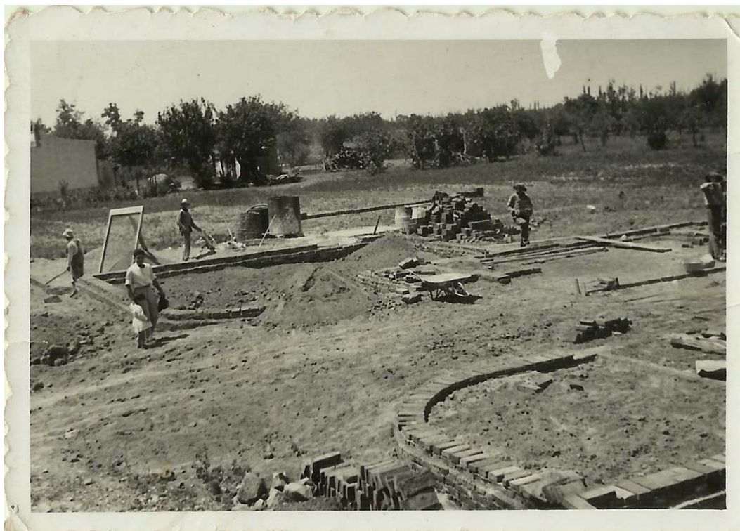
Fotografía 2: Socios trabajando en la construcción del edificio de la Biblioteca
