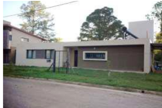
Figura 8. Caso de estudio vivienda con uso de colector solar.
