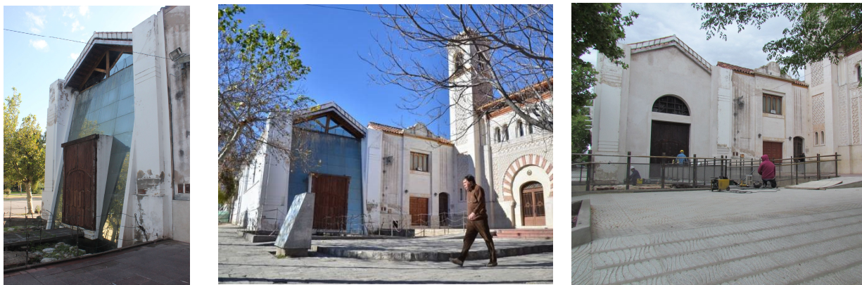
Fachada Antiguo Templo de Santo Domingo. Informe Final Proyecto de Adecuación, 2016.
