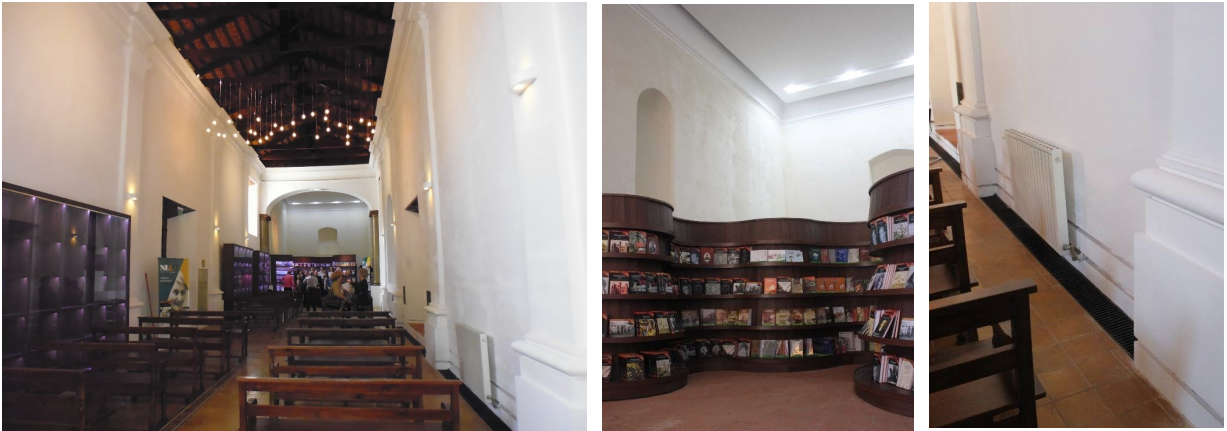
Interior Antiguo Templo de Santo Domingo. Informe Final Manual de mantenimiento, 2016.
