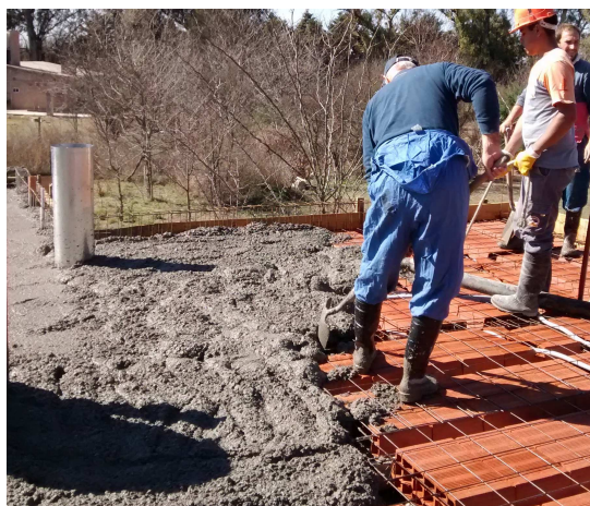
Figura 1. Elementos componente de la losa de viguetas.
