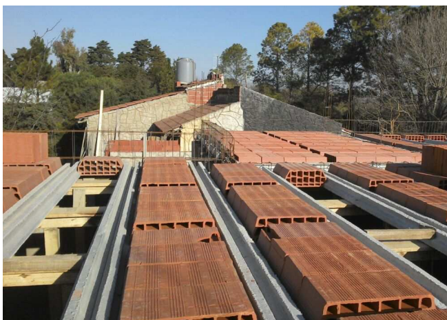
Figura 1. Elementos componente de la losa de viguetas.
