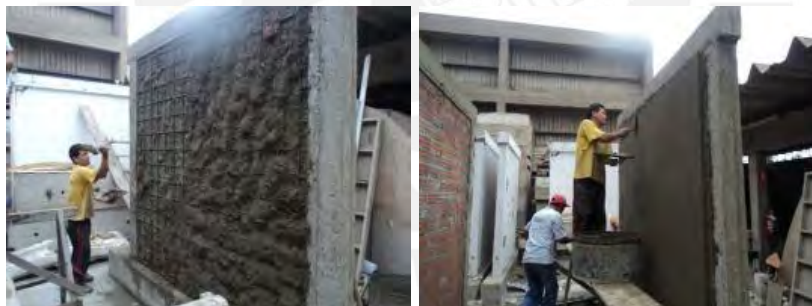
Figura 6.30. Proceso constructivo del muro MRI-SCA-AV (Araoz y Velezmoro, 2012)
