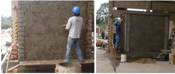
Figura 6.36. Tarrajeo del muro y las columnas (Mamani, 2015)
