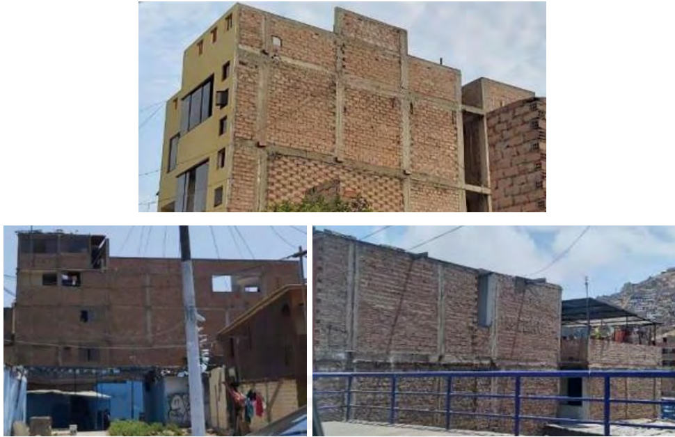
Figura 2.1. Viviendas de albañilería confinada tubular
