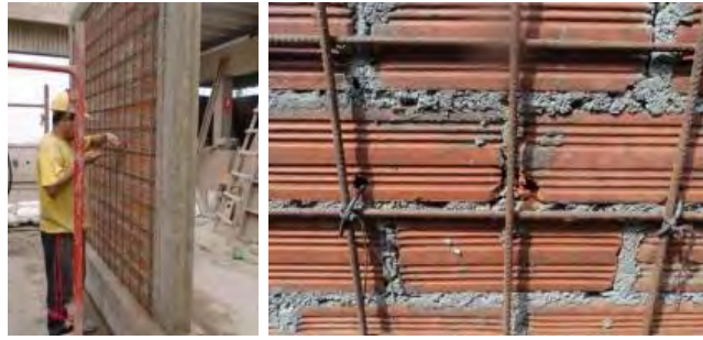
Figura 6.29. Colocación de la malla electrosoldada (Araoz y Velezmoro, 2012)
