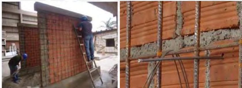
Figura 6.35. Colocación y conexión de las mallas (Mamani, 2015)
