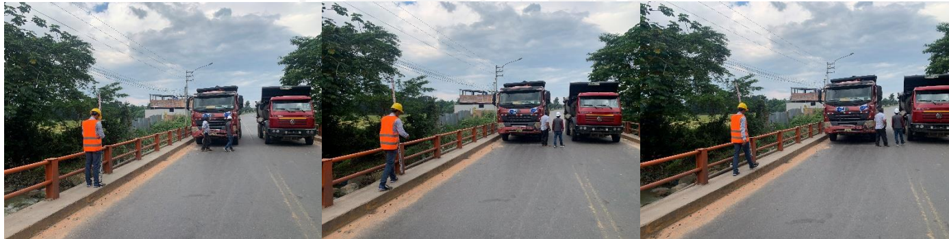
Figura 4. 18: Aplicación del Estado de Carga N ° 02 – Aguas Abajo - Prueba de Carga (Fuente: Elaboración propia).
