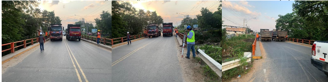
Figura 4. 16: Aplicación del Estado de Carga N° 01 – Aguas Arriba - Prueba de Carga (Fuente: Elaboración propia).
