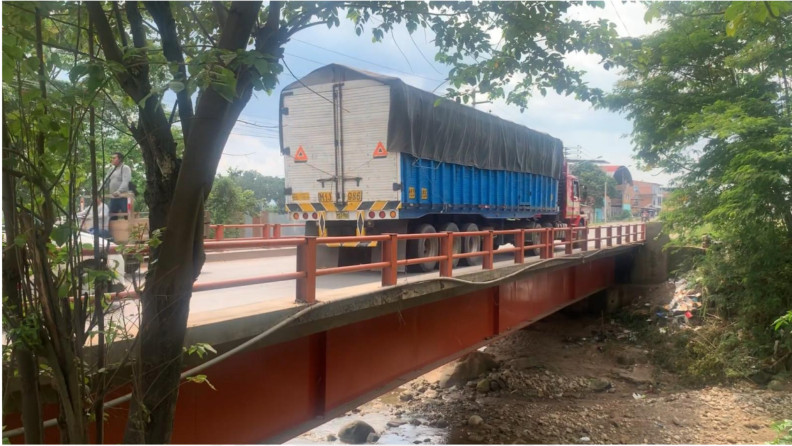
Figura 4. 2: Puente en servicio (Fuente: Elaboración propia).
